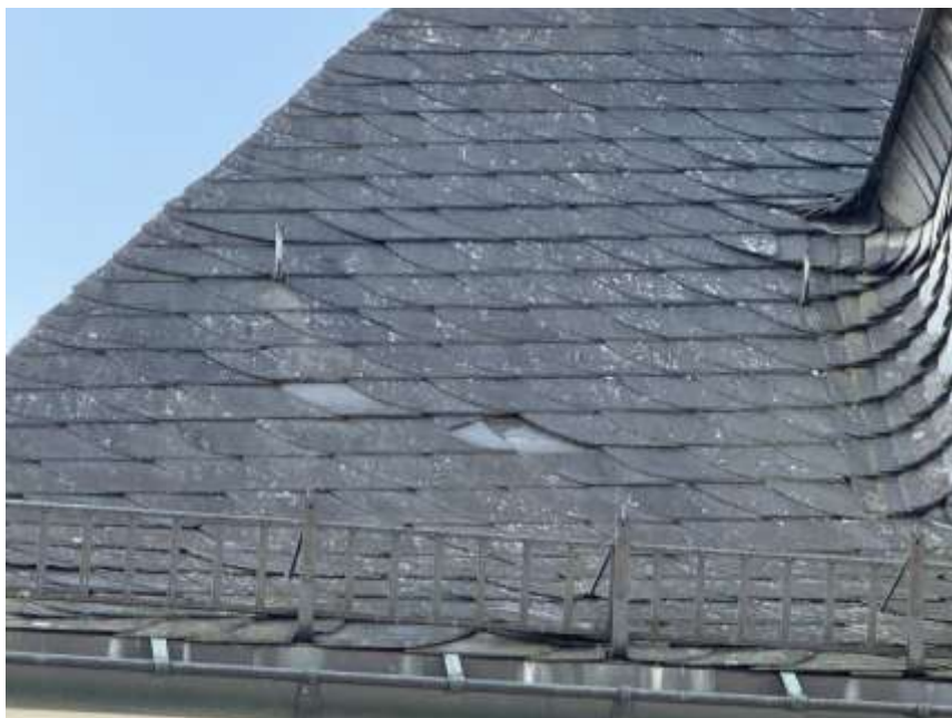
Bild 16: Beispiel für lockere Schiefersteine auf dem Hausdach
