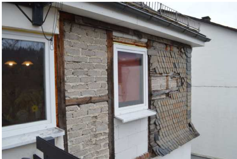
Bild 16: defekte Fassadenverkleidung
