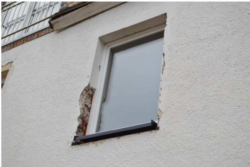
Bild 18: defekte Fensterlaibung
