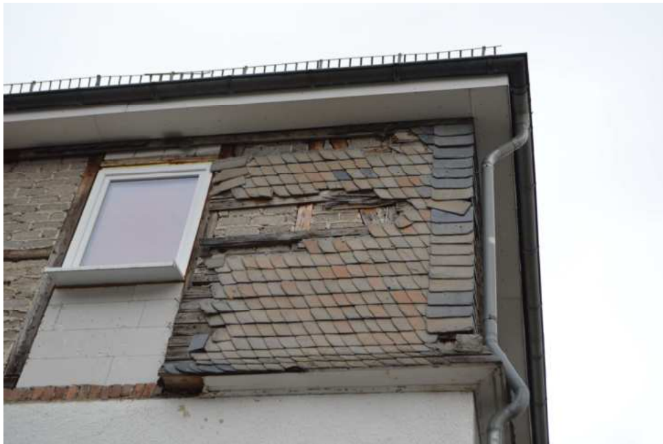
Bild 17: defekte Fassadenverkleidung
