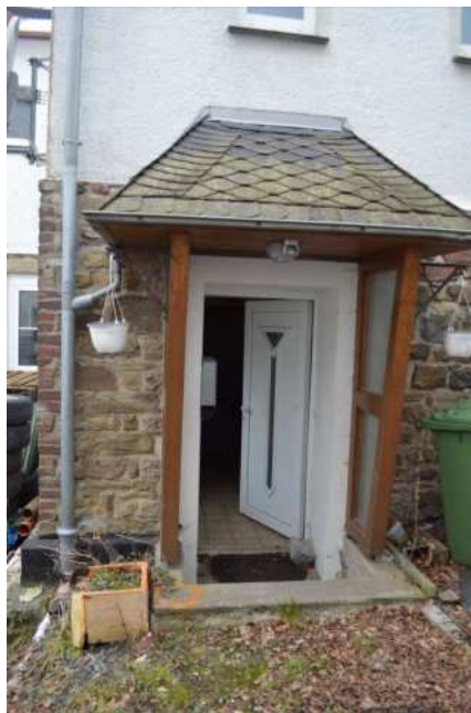
Bild 14: Zugang zum „wohnähnlich“ ausgebauten Bereich
