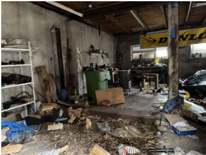
Bild 18: Blick in die Garage
