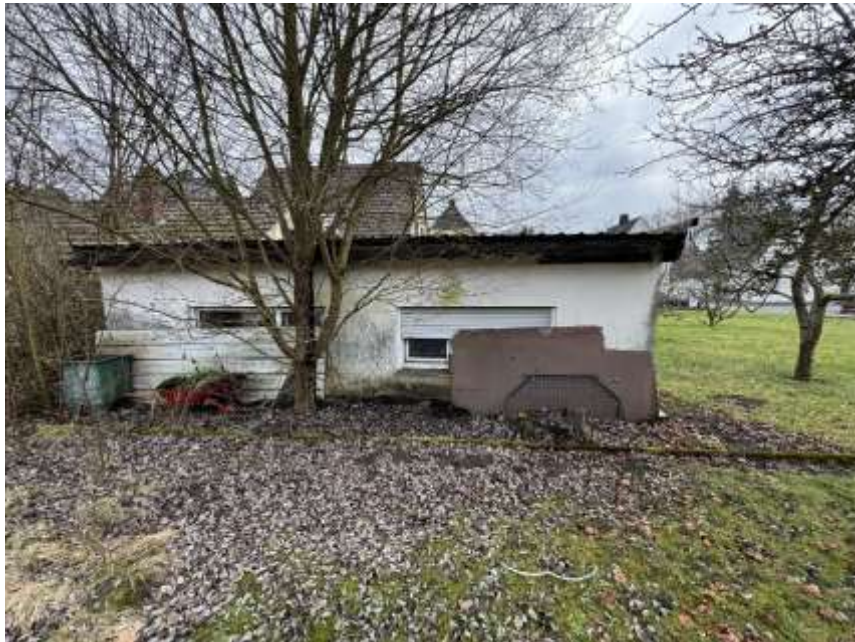
Bild 5: Westansicht, Rückseite der Garage
