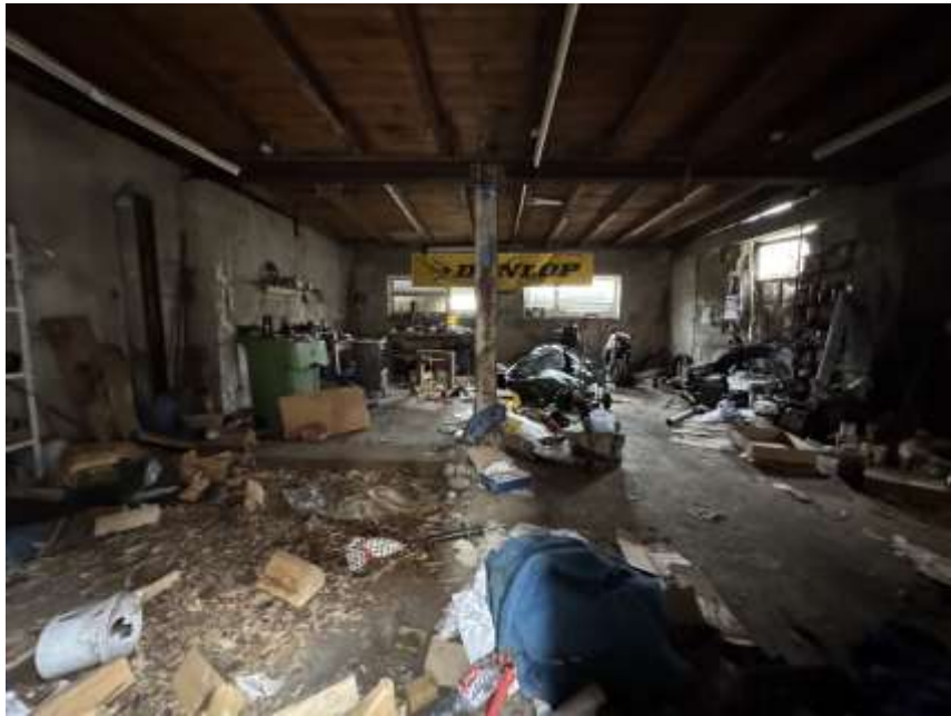
Bild 17: Blick in die Garage
