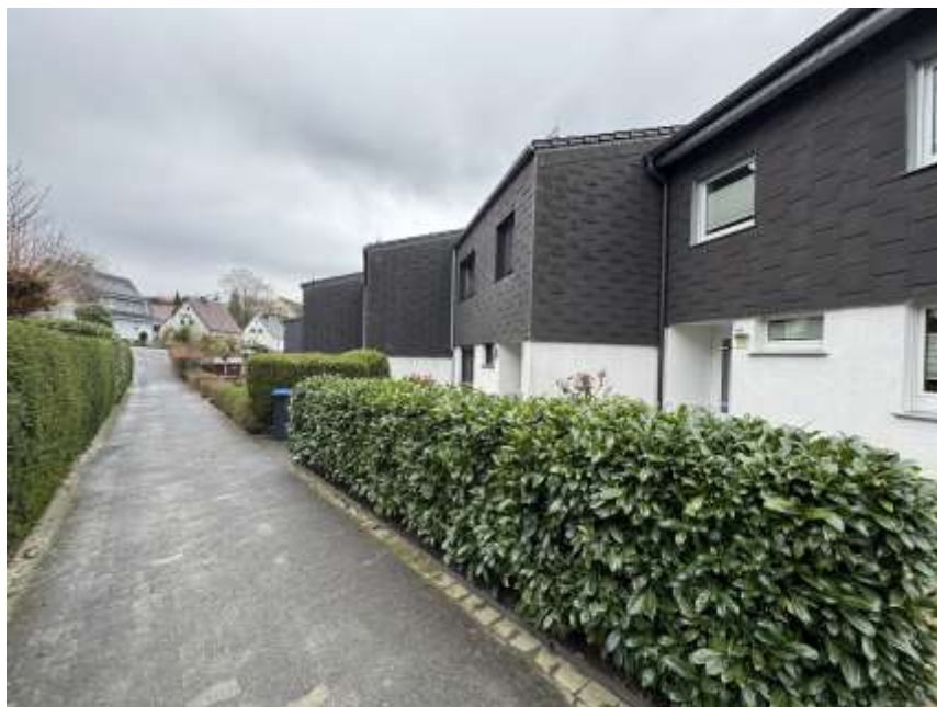
Bild 2: Zufahrt vor den Reihenhäusern
