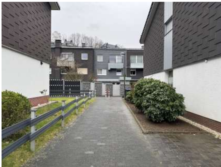
Bild 4: Weg neben den Reihenhäusern
