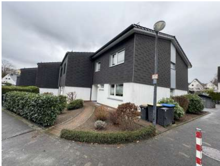
Bild 3: Weg neben den Reihenhäusern
