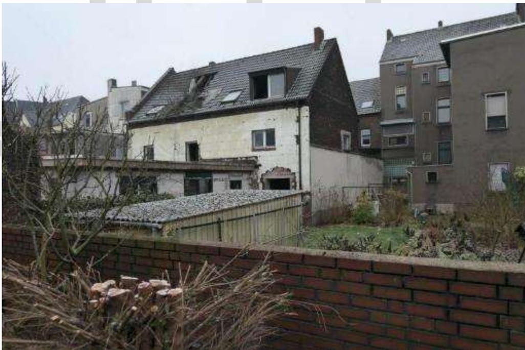
Bild 18 Blick auf die Rückseite des Hinterhauses mit Dachschaden
