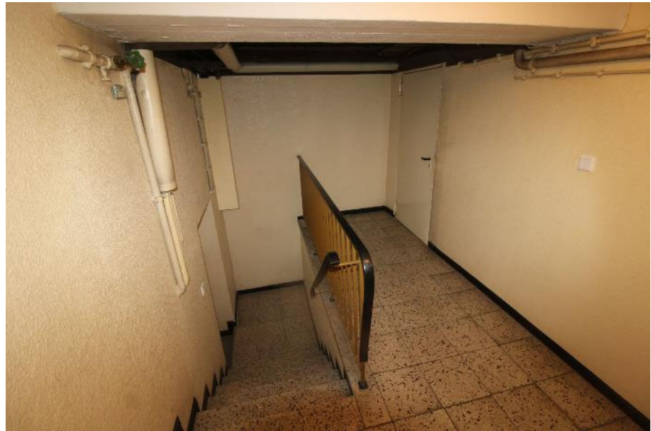
Sicht in das Treppenhaus / KG Haus Nr. 30
