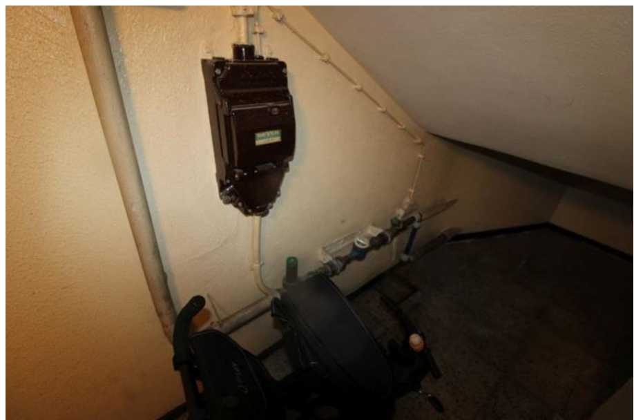
Sicht in das Treppenhaus / KG Haus Nr. 30
