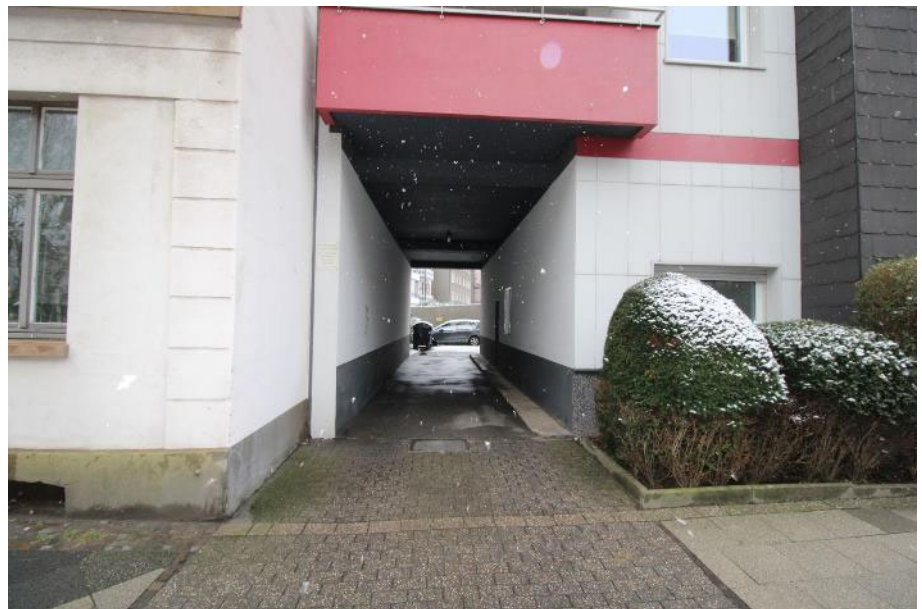
Sicht von der Straße aus auf die Durchfahrt im Haus Nr. 30
