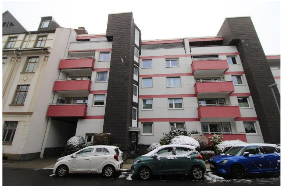
Sicht von der Straße aus auf die Vorderfas- sade des Hauses Nr. 30, in dem sich die zu bewertende Woh- nung Nr. 2 befindet
