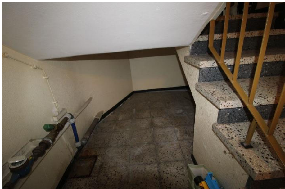
Sicht in das Treppenhaus / KG Haus Nr. 30
