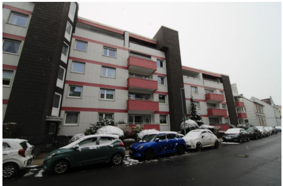
Sicht von der Straße aus auf die Vorderfas- sade der Häuser Nr. 26 und Nr. 28
