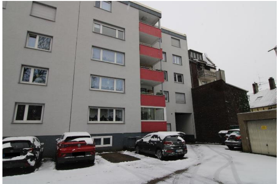
Sicht vom Hof aus auf die Rückfassade des Hauses Nr. 30, in dem sich die zu bewertende Wohnung Nr. 2 befindet
