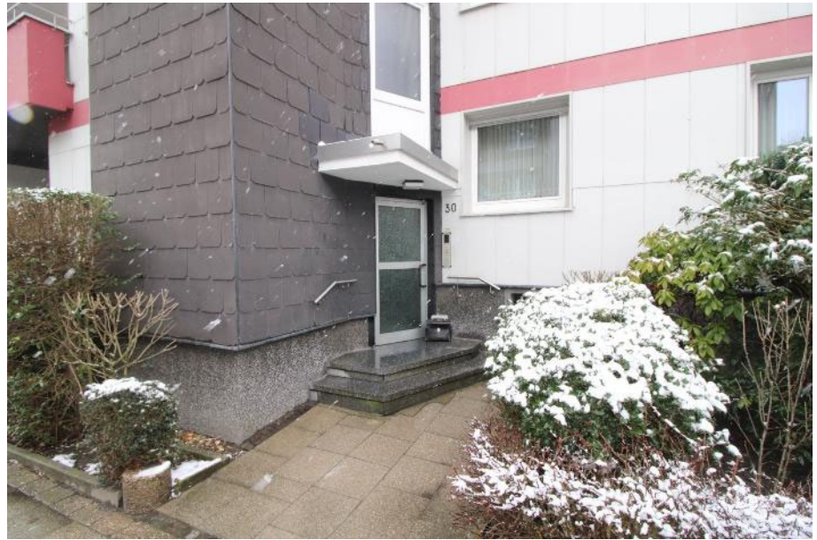
Sicht vom Gehweg aus auf den Hausein- gang Nr. 30
