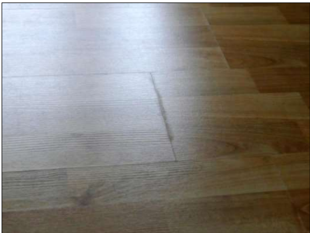
schadhafte Bodenbeläge
