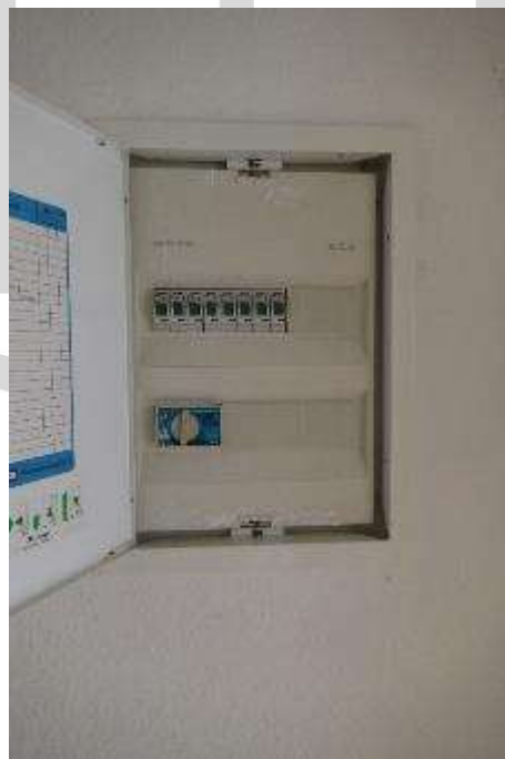
Bild 18 Elektrounterverteilung
