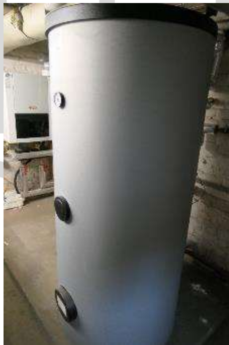
Bild 16 zentraler Warmwassertank
