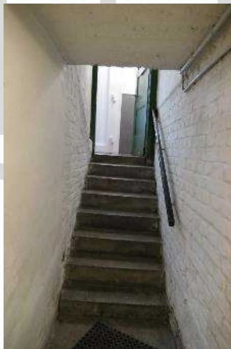
Bild 12 Treppe zum Kellergeschoss
