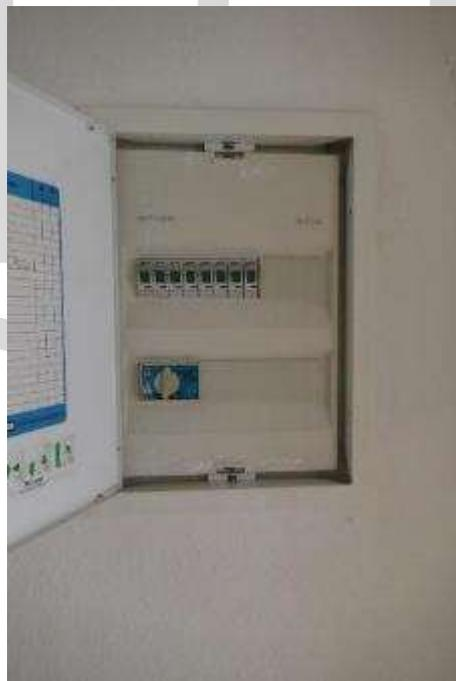
Bild 18 Beispiel einer Elektronterverteilung
