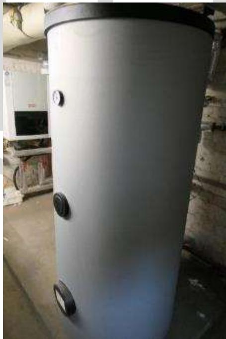
Bild 16 zentraler Warmwassertank
