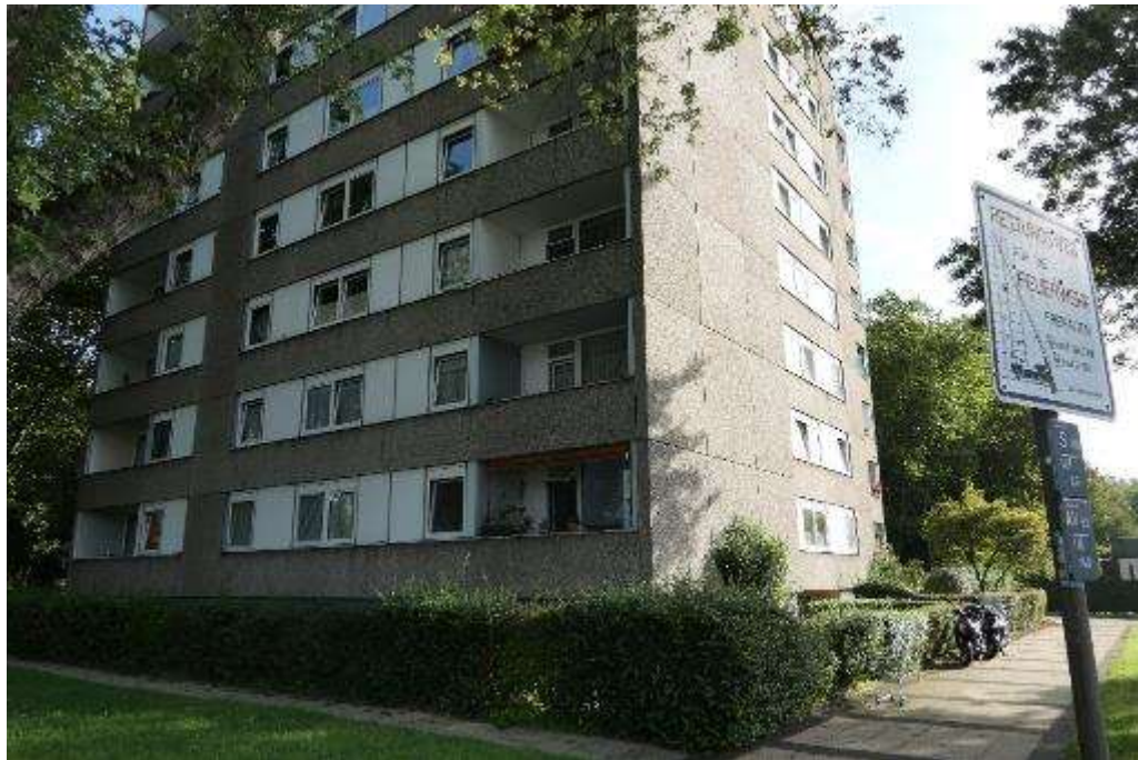
Bild 3 Ansicht westliche Fassade
