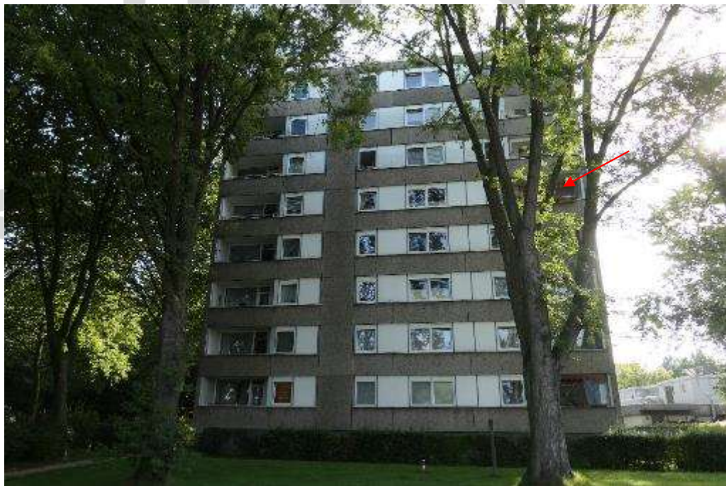
Bild 4 Ansicht westliche Fassade mit Loggia der Wohnung Nr. 49
