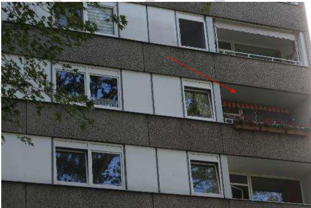
Bild 6 Loggia der Wohnung
