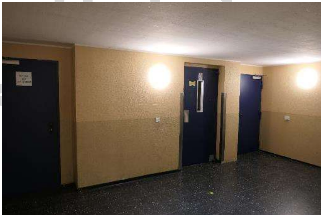
Bild 22 Aufzug Hauseingangsebene gesperrt
