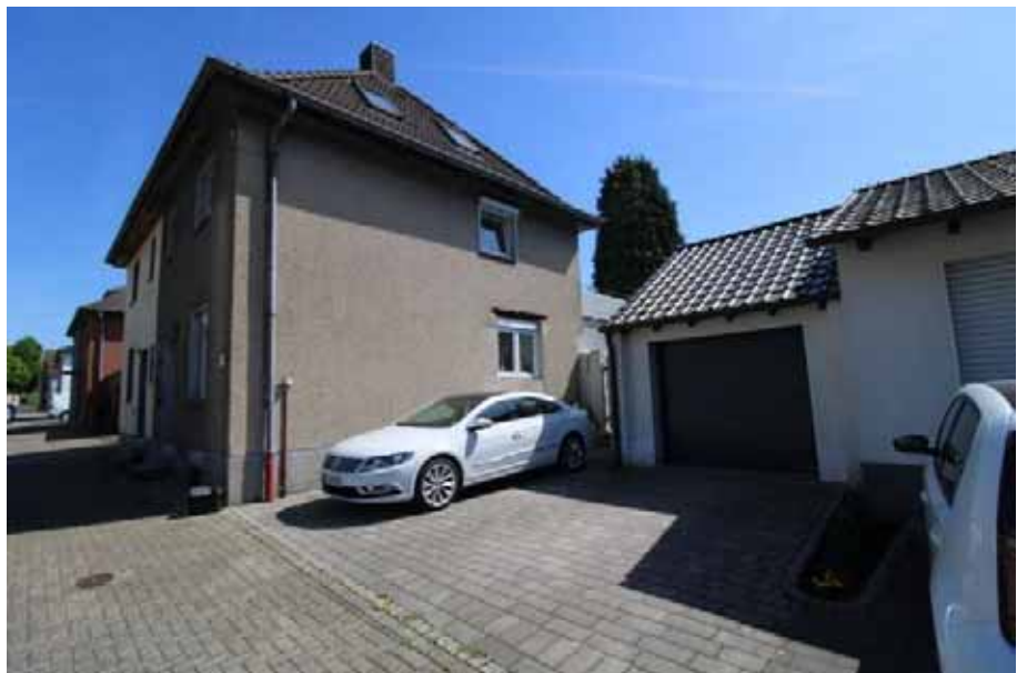
Sicht vom Gehweg aus auf die Giebelfas- sade des Wohnhauses
