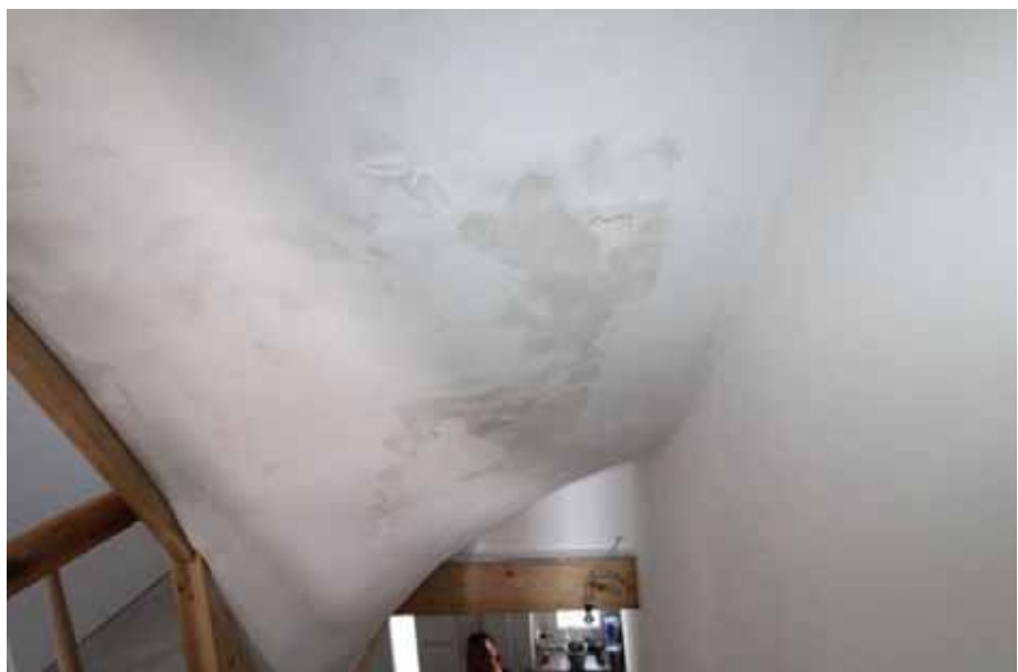
Sicht auf Spachtel- und Malerarbeiten an der Unterseite der in- ternen Treppe / OG
