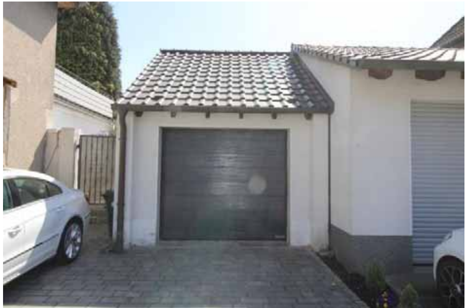
Sicht vom Gehweg aus auf die Vorderfas- sade der Garage
