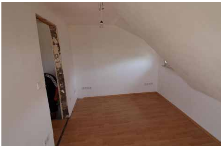
Sicht in den Raum 1 / DG
