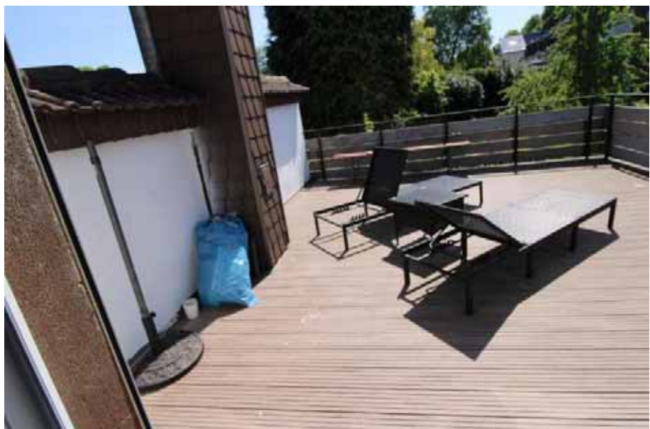
Sicht auf die Dachter- rasse / OG
