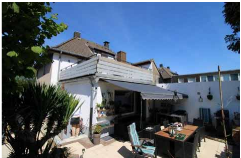
Sicht von der Terrasse aus auf den Anbau
