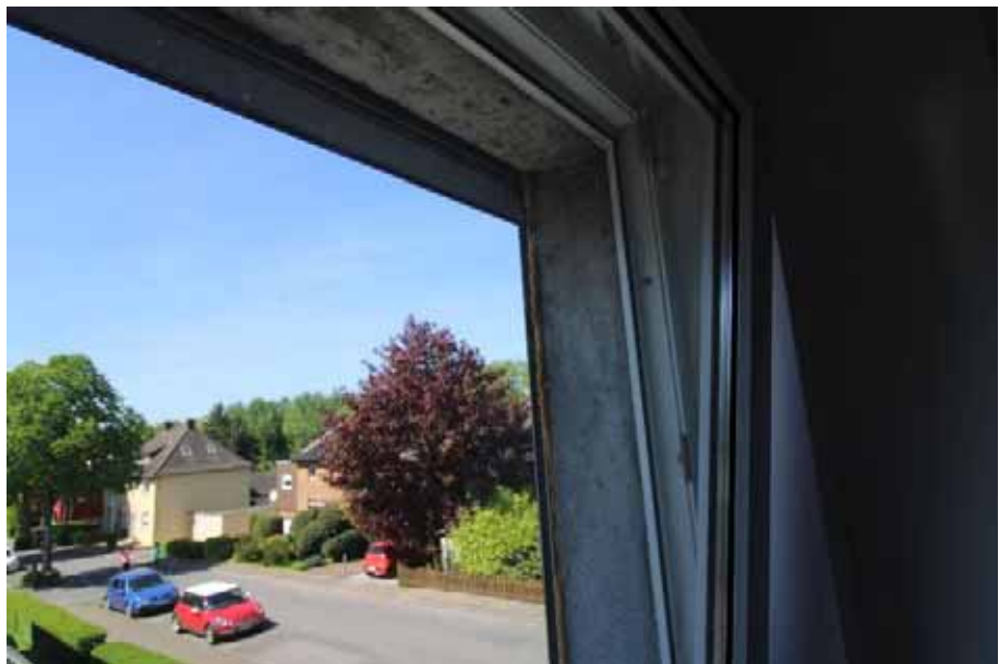
Sicht auf fachgerechte Anschlussarbeiten der Fassade am Fenster an der Giebelfassade, im Zimmer 2 / OG
