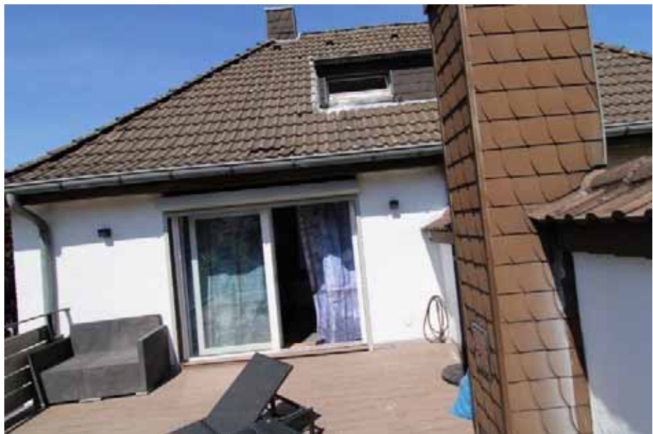
Sicht auf die Dachter- rasse / OG
