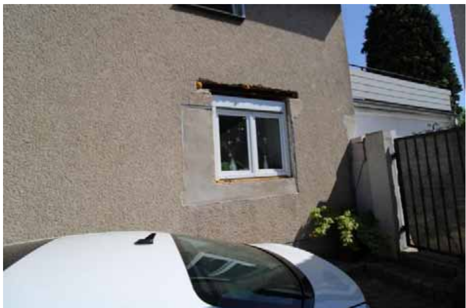
Sicht auf fachgerechte Anschlussarbeiten der Fassade am Fenster im Erdgeschoss, an der Giebelfassade
