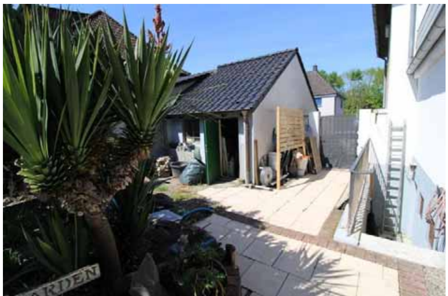
Sicht von der Terrasse aus auf die Rück- und Giebelfassade der Ga- rage
