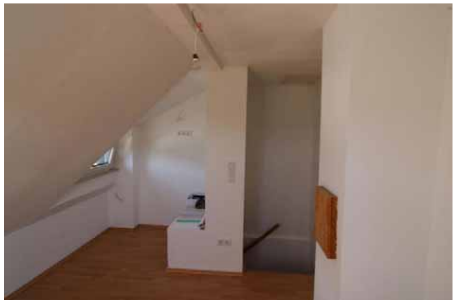
Sicht in den Raum 2 / DG
