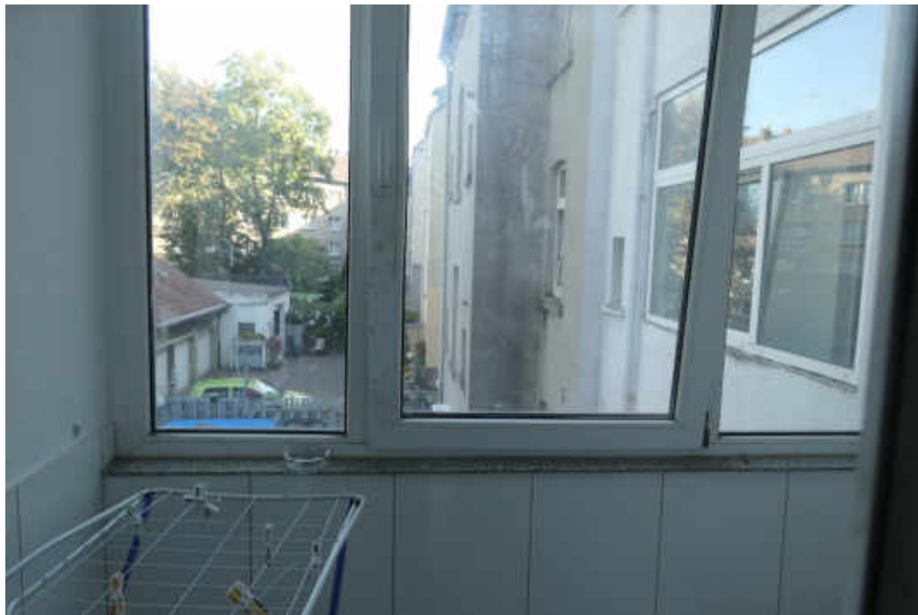
Bild 15 Balkon mit Kunststoffverglasung
