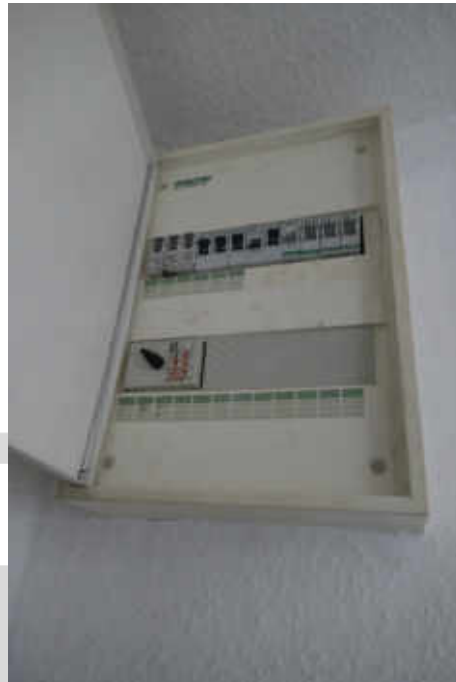
Bild 19 Sicherungskasten
