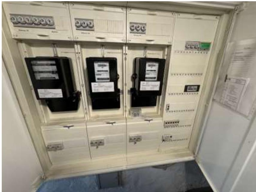
Bild 19: Elektroverteilung im Kellergeschoss
