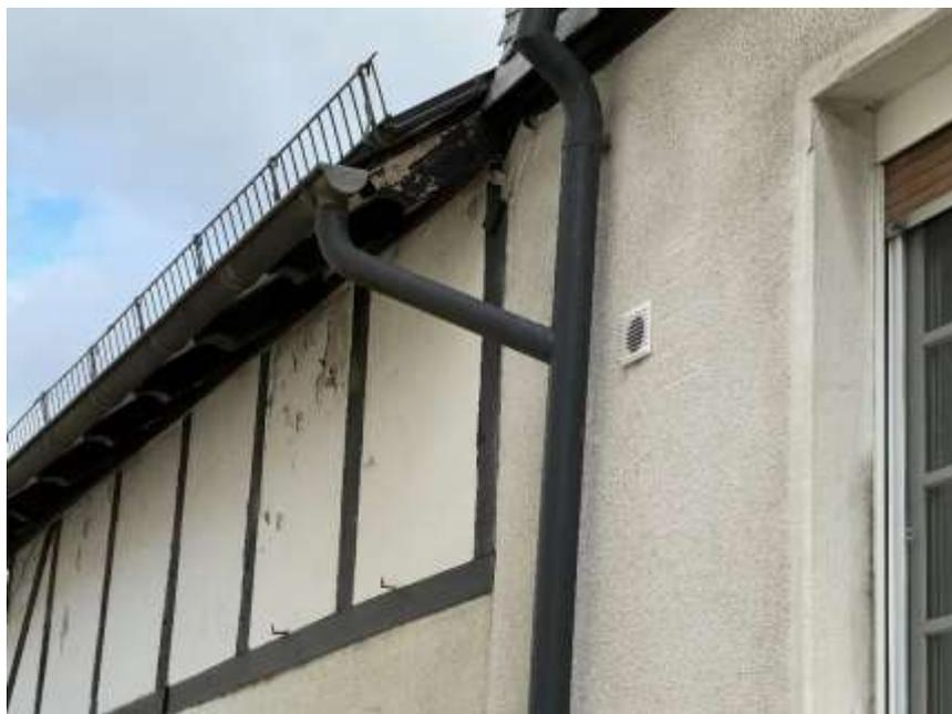
Bild 4: Süd-/Westseite, Beispiel für Beschädigungen an der Fassade und am Dachüberstand
