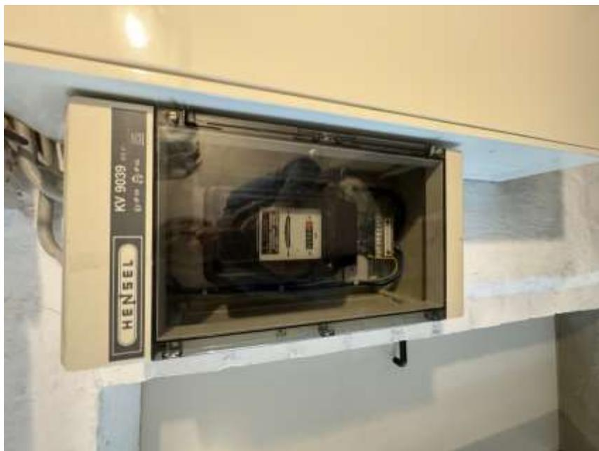
Bild 20: Hauptzähler Elektro im Kellergeschoss
