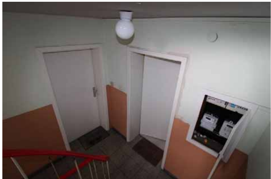
Sicht in das Treppenhaus / 1.OG
