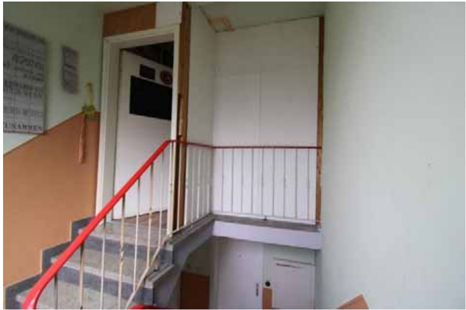
Sicht in das Treppenhaus / DG
