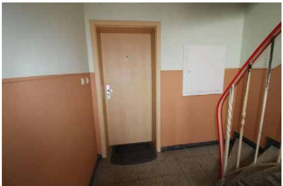
Sicht vom Treppenhaus aus auf die Wohnungstür / EG
