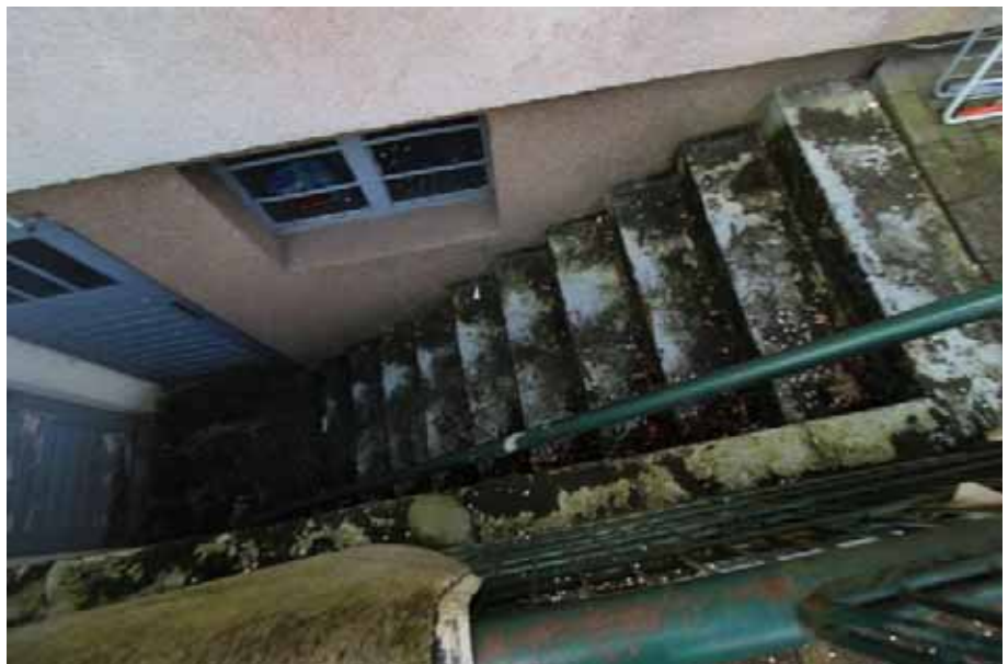
Sicht auf die Kelleraußentreppe hinter dem Wohnhaus
