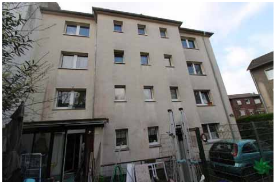
Sicht vom Garten aus auf die Rückansicht des Wohnhauses
