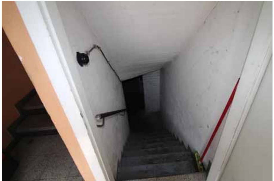
Sicht vom Treppenhaus aus auf die Kellertreppe / EG
