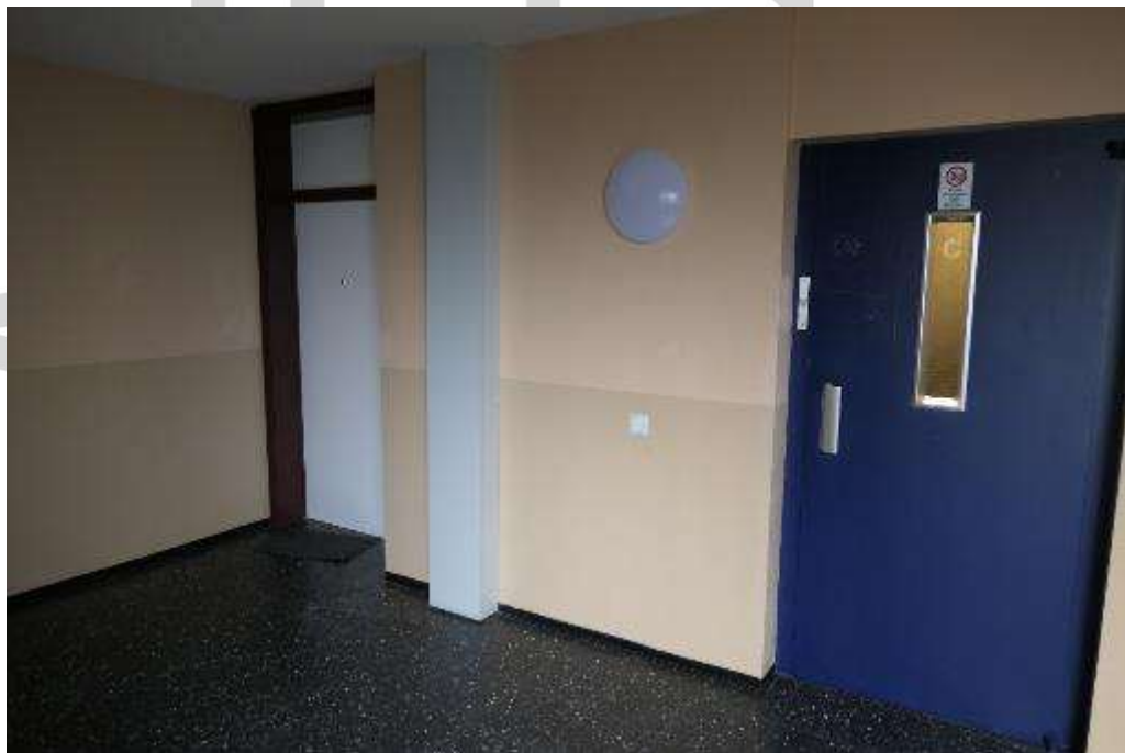
Bild 16 Aufzug fünftes Obergeschoss
