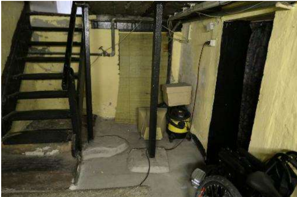
Bild 19 Flur im Kellergeschoss
