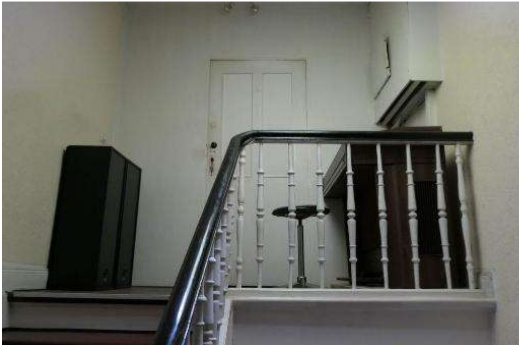
Bild 25 Treppenhaus im Dachgeschoss
