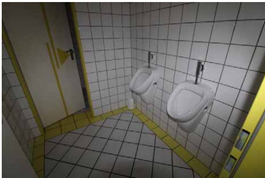
Sicht in ein WC im Turm/2.OG Haus 1 (Shamrockring 1)
