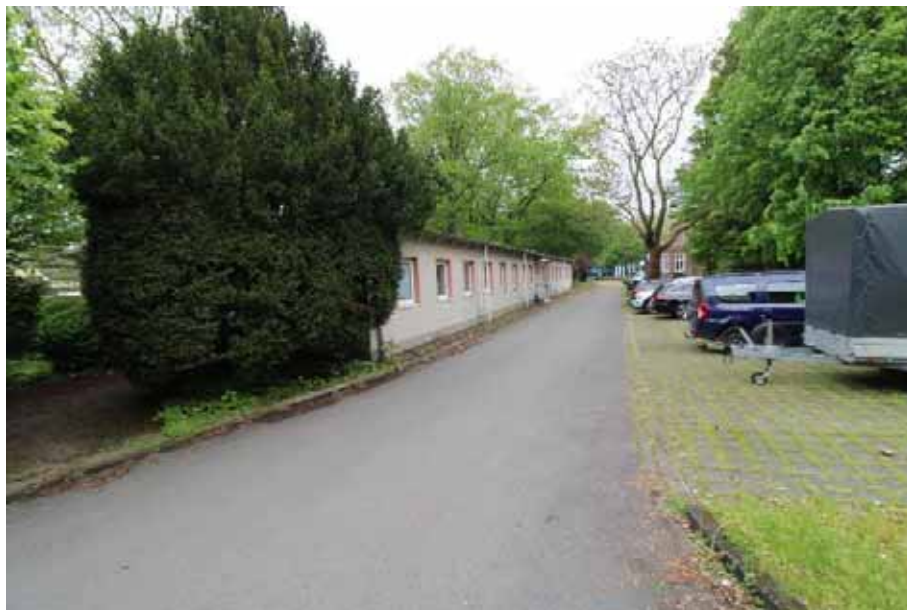
Sicht auf die Ostfas- sade von Haus 9 und den Parkplatz P6
