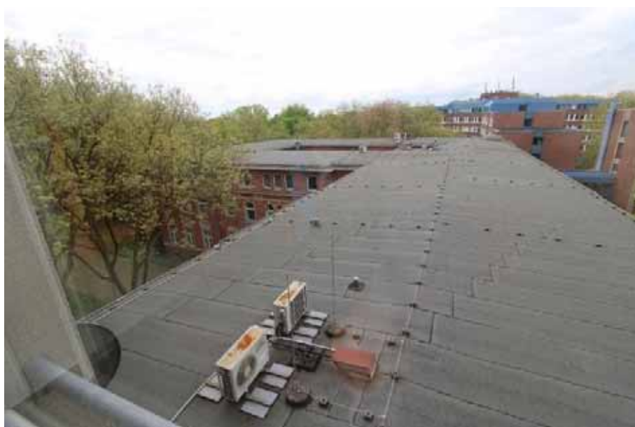
Sicht vom Turm aus auf das Flachdach/ 4.OG Haus 1 (Sham- rockring 1)
