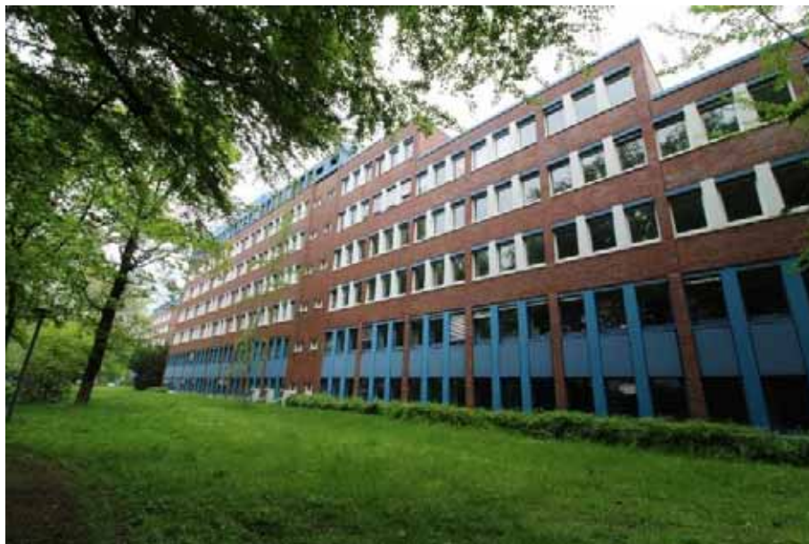
Sicht auf die Westfas- sade von Haus 4 (Shamrockring 9)
