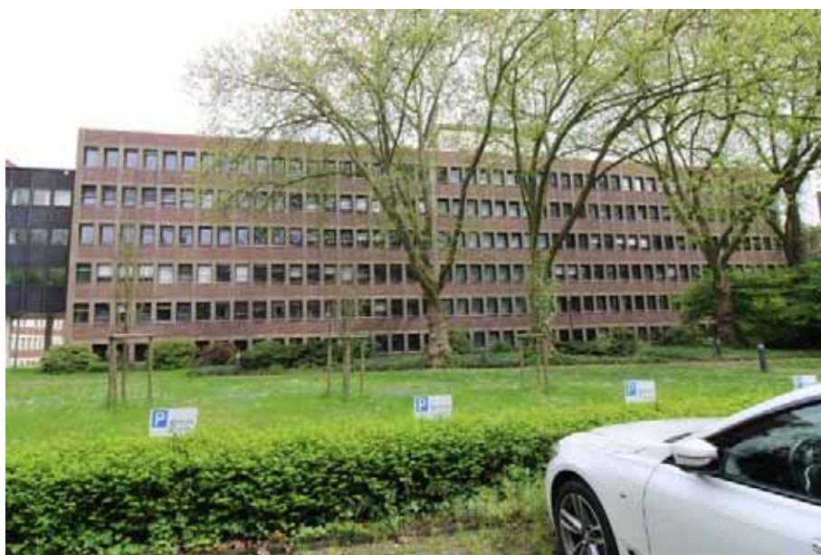
Sicht auf die Westfas- sade von Haus 2 (Shamrockring 13)
