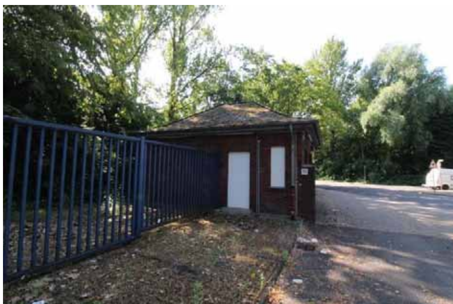
Sicht auf die Nordfas- sade von Haus 13 (Grenzweg 119)
