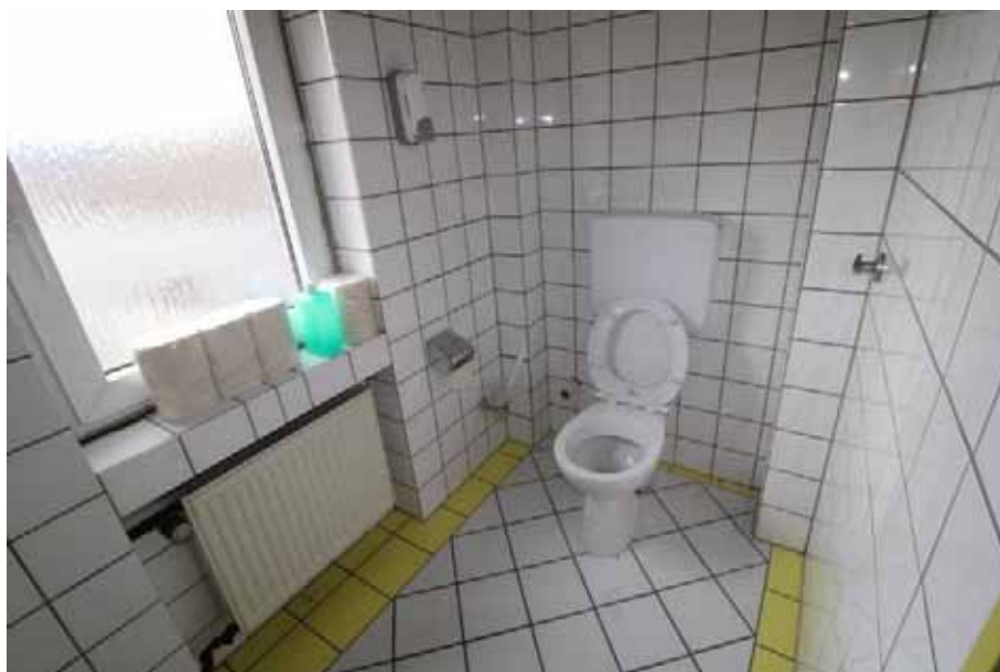
Sicht in ein WC im Turm/3.OG Haus 1 (Shamrockring 1)
