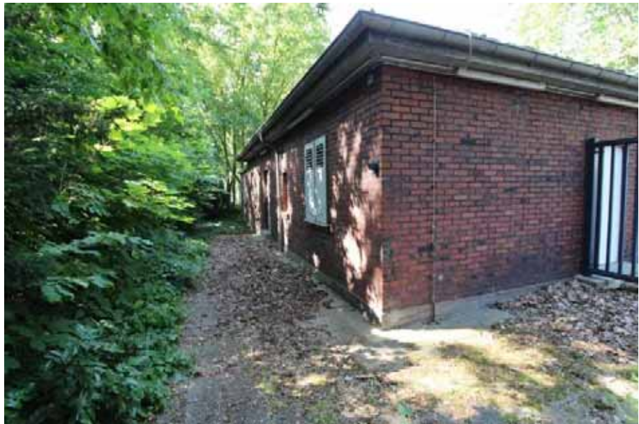
Sicht auf die Nordost- fassade von Haus 13 (Grenzweg 119)
