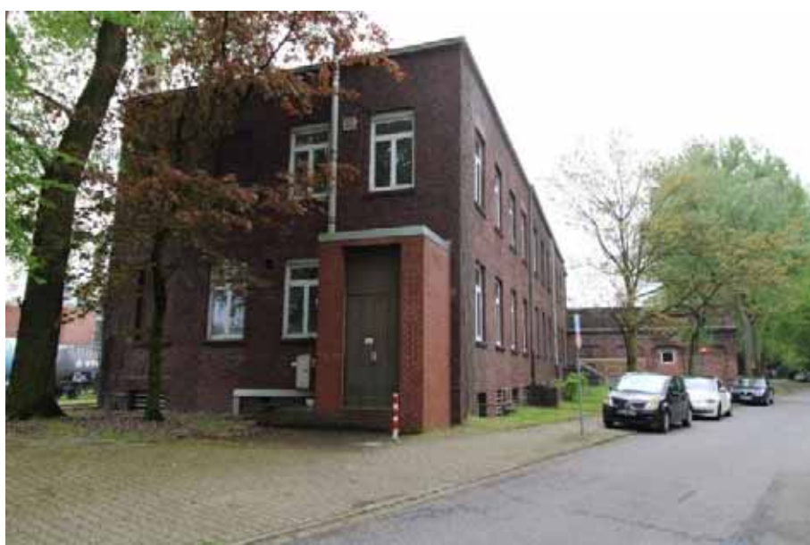
Sicht auf die Nordfas- sade von Haus 6 (Shamrockring 10+11)
