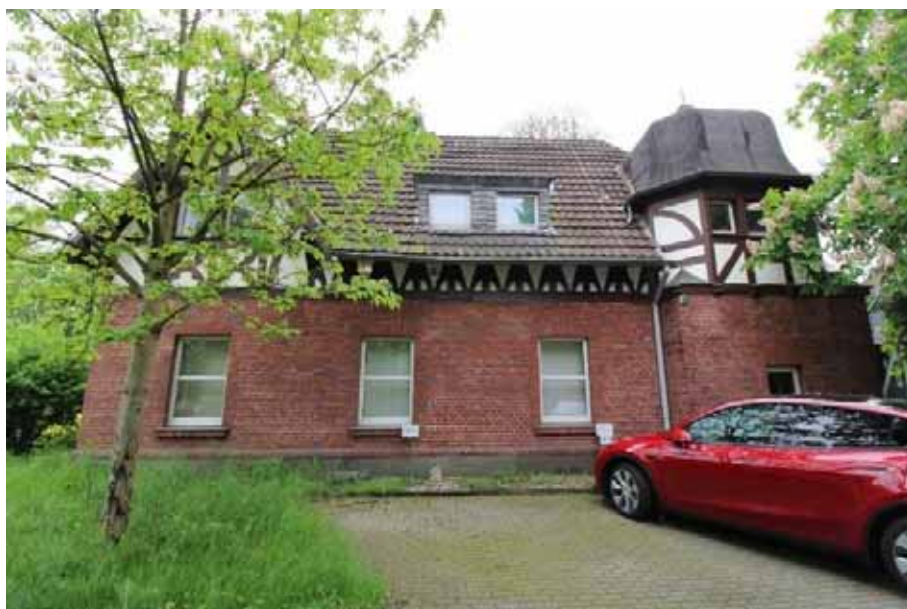
Sicht vom Shamrock- ring aus auf die Ost- fassade von Haus 11 (Shamrockring 4a)
