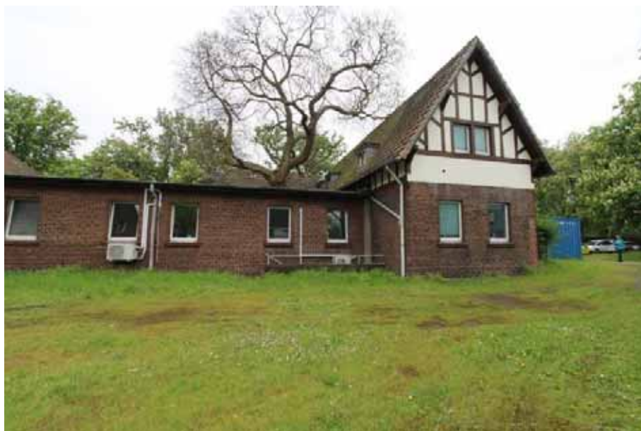
Sicht auf die Westfas- sade von Haus 11 (Shamrockring 4a)
