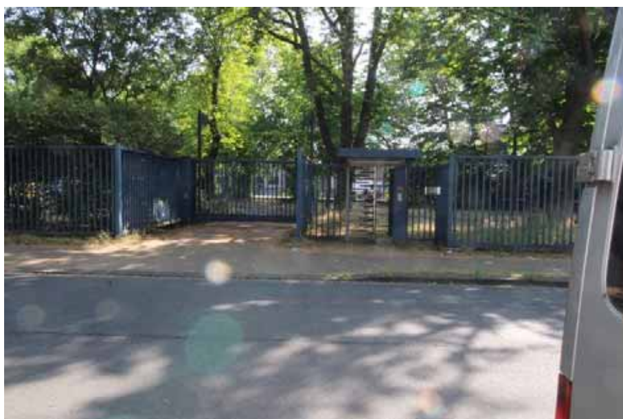
Sicht vom Grenzweg aus auf die Zuwegung im südlichen Grund- stücksbereich
