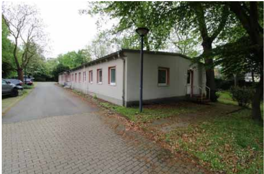
Sicht auf die Nordost- fassade von Haus 9
