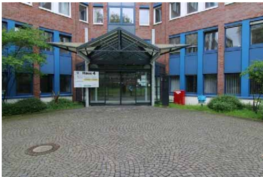
Sicht auf den Haupteingang an der Nordostfassade von Haus 4 (Shamrockring 9)
