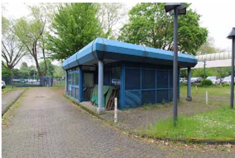
Sicht auf das ehemals genutzte Pförtnerhaus (Haus 12) und die ehemals genutzte Zu- fahrt
