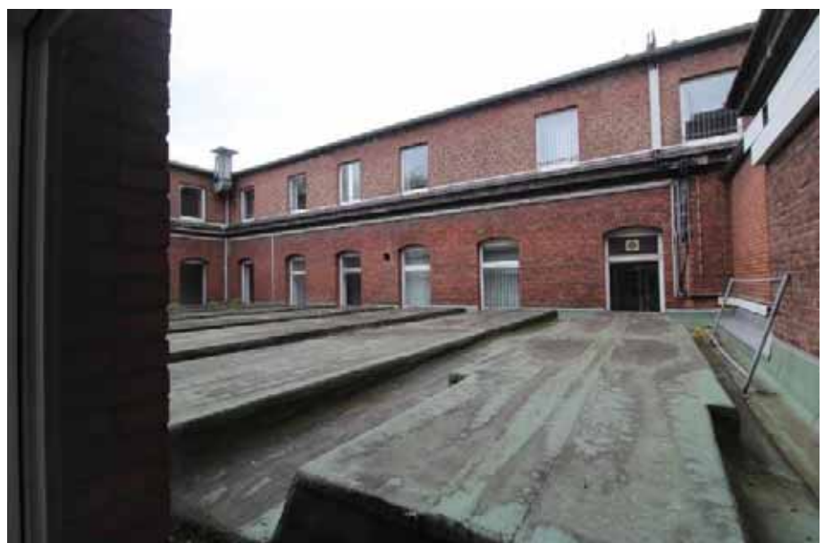
Sicht auf das Flach- dach vom Atrium/ 1.OG Haus 1 (Sham- rockring 1)
