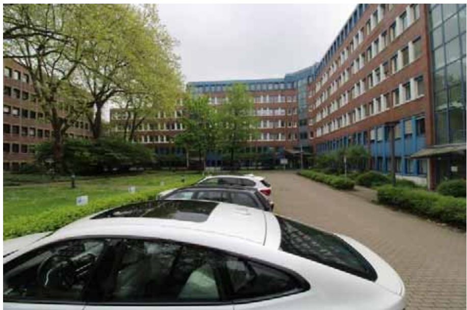
Sicht auf die Ostfas- sade von Haus 4 (Shamrockring 9)
