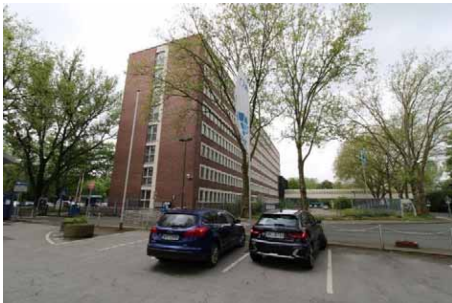
Sicht vom Parkplatz P10 aus auf die Nord- ostfassade von Haus 3 (Shamrockring 15)
