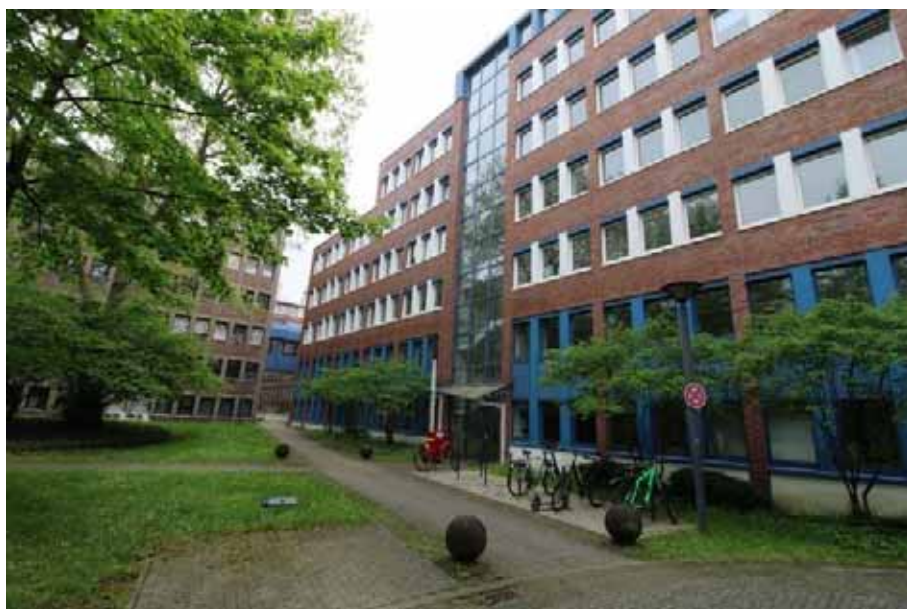
Sicht auf die Nordfassade von Haus 4 (Shamrockring 9)
