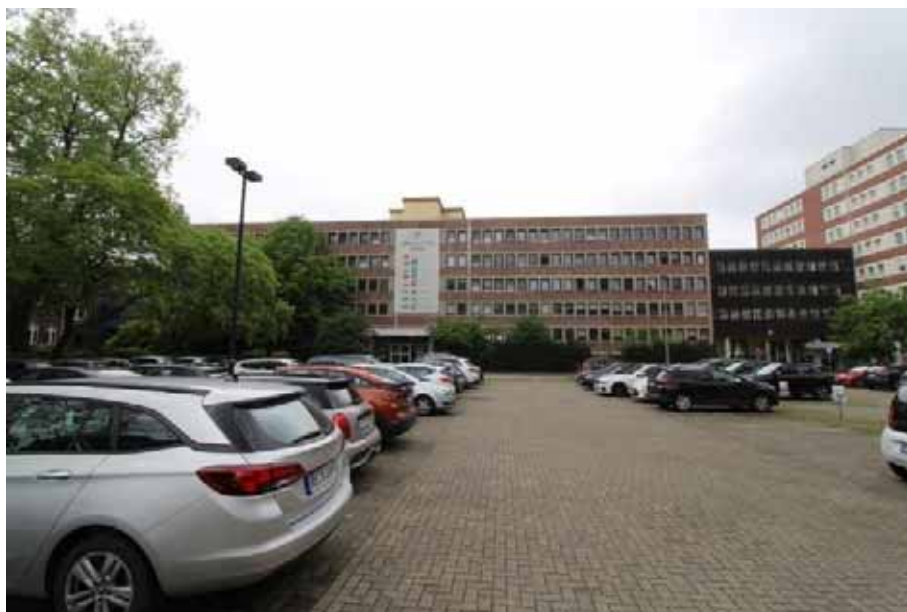
Sicht auf die Ost- fassade von Haus 2 (Shamrockring 13)
