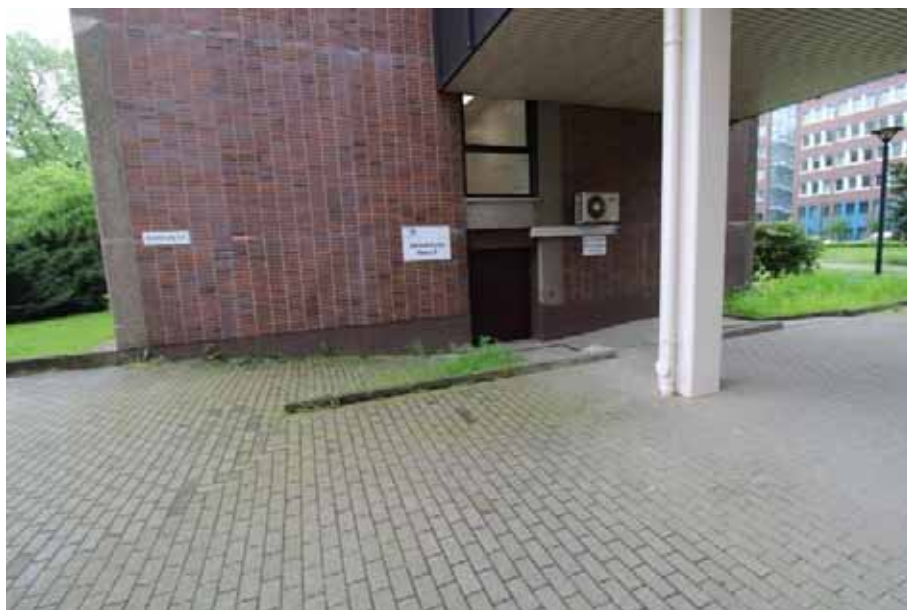
Sicht auf den Nebeneingang an der Nordfassade von Haus 2 (Shamrockring 13)
