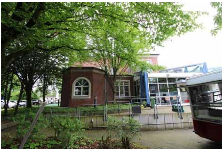
Sicht auf die Ostfas- sade von Haus 8 (Shamrockring 3 / Casino)
