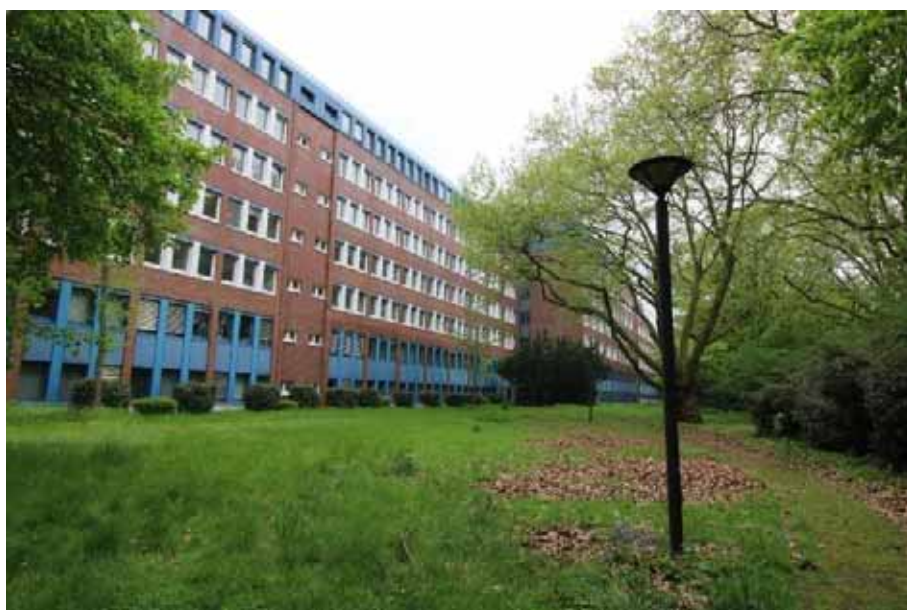
Sicht auf die Westfassade von Haus 4 (Shamrockring 9)
