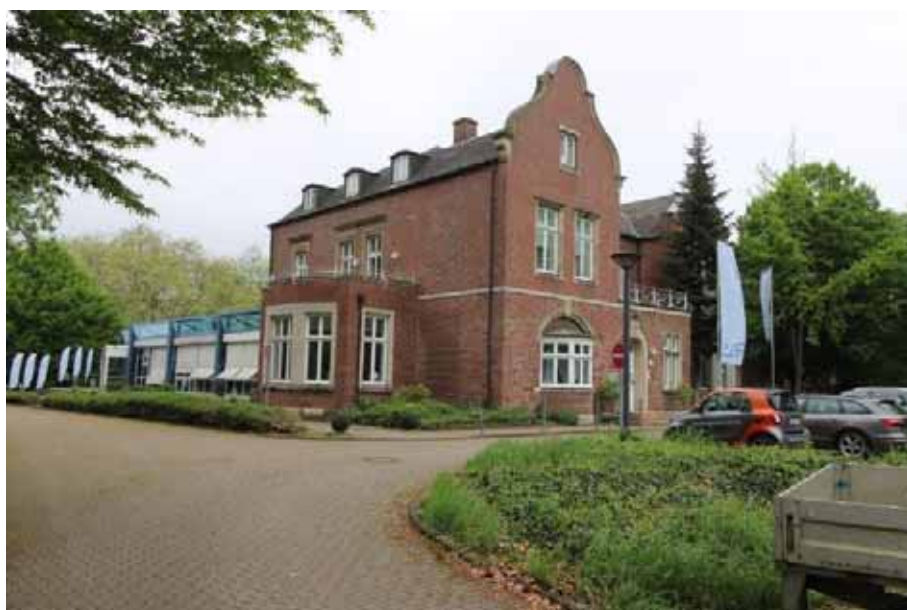
Sicht auf die Südwest- fassade von Haus 8 (Shamrockring 3 / Casino)
