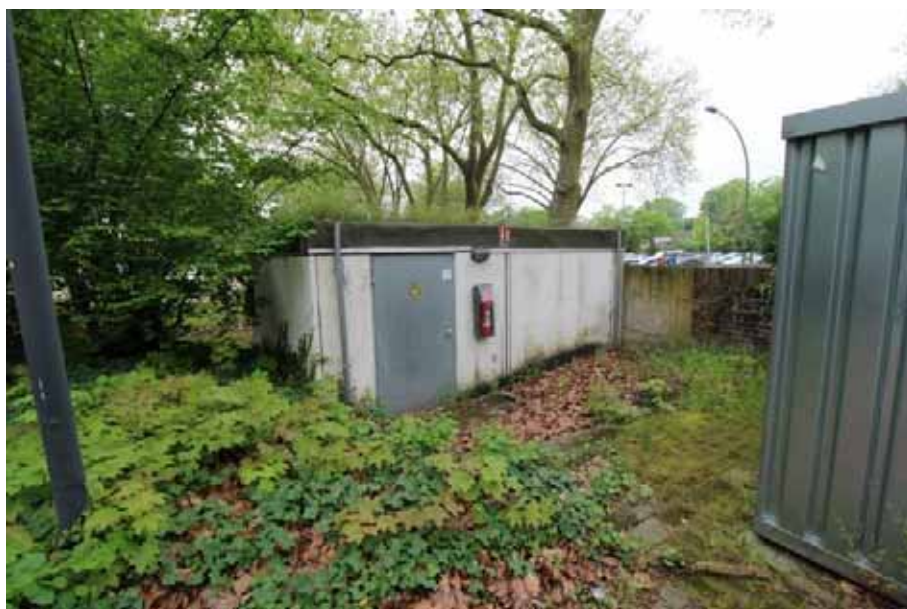
Sicht auf das Haus 28 (Transformator- häuschen)
