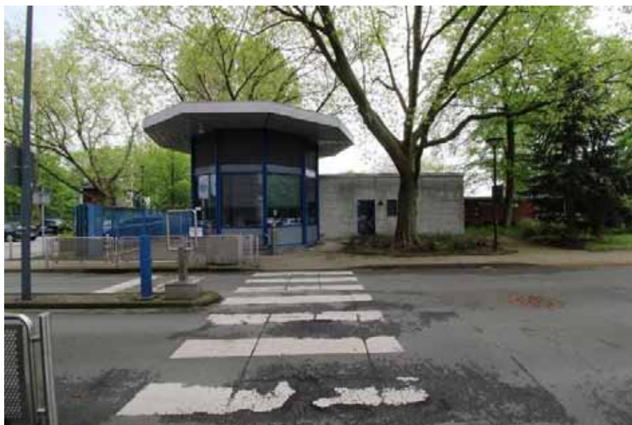
Sicht auf die Westfas- sade von Haus 21 (Pförtner)
