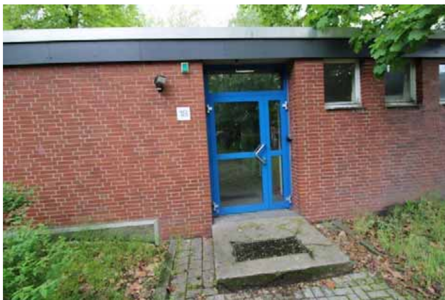
Sicht auf den Eingang an der Südfassade von Haus 18
