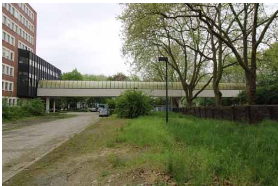
Sicht vom Parkplatz P1 aus auf die Verbin- dungsbrücke von Haus 3 an der Nordfassade (Shamrockring 15) be- ginnend über die Brunnenstraße hinweg
