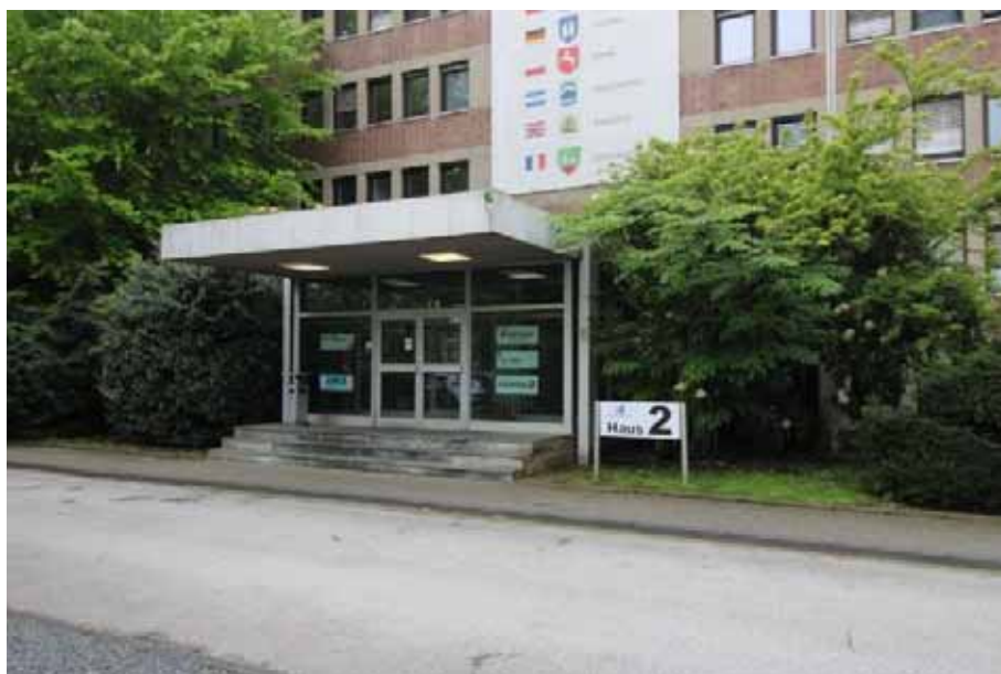
Sicht auf den Haupt- eingang an der Ost- fassade von Haus 2 (Shamrockring 13)
