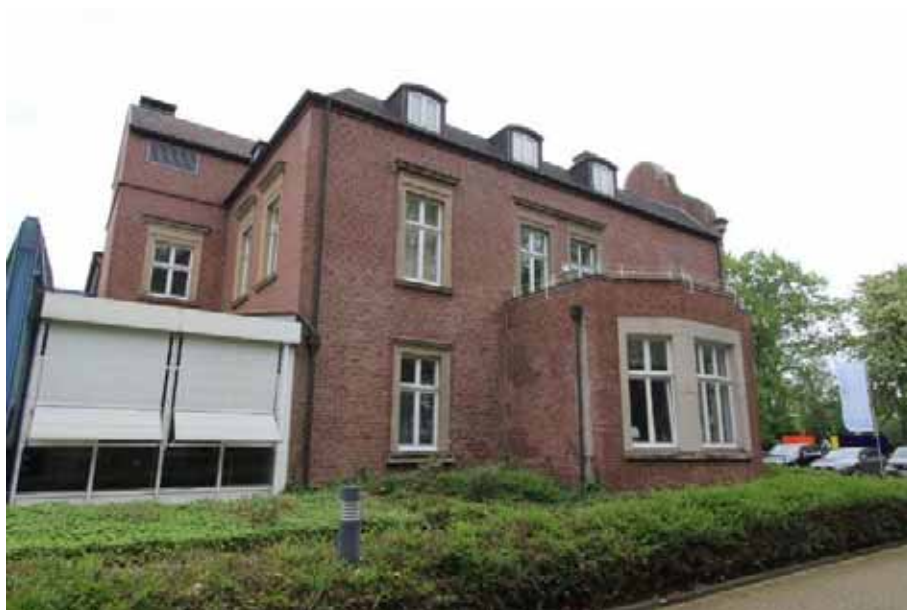
Sicht auf die Westfas- sade von Haus 8 (Shamrockring 3 / Casino)
