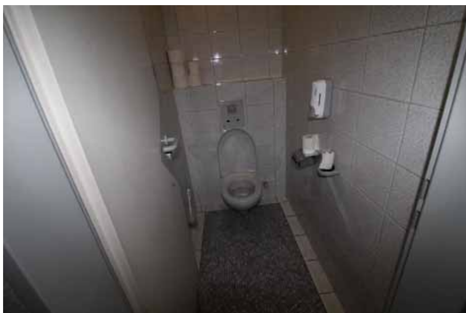
Sicht in ein WC/ EG Haus 1 (Sham- rockring 1)
