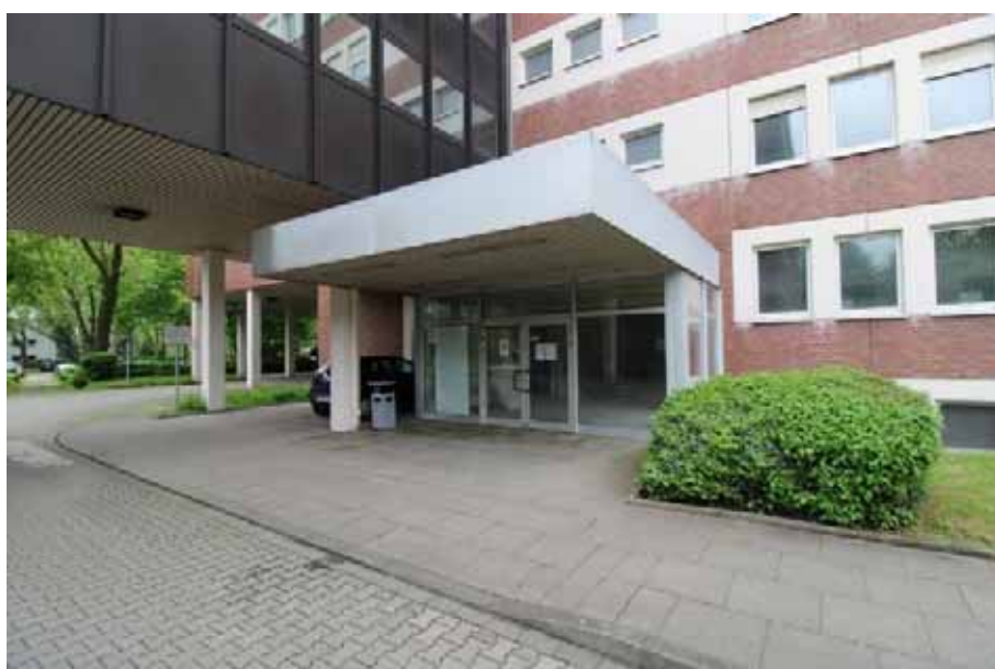
Sicht auf den linken Haupteingang an der Südfassade von Haus 3 (Shamrockring 15)
