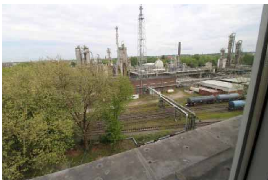
Sicht vom Turm aus auf das Nachbargrund- stück (Flurstück 928)
