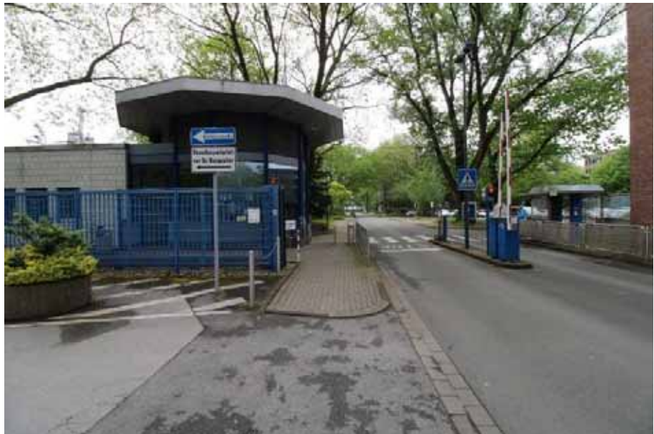
Sicht von der Brunnen- straße aus auf die Zu- fahrt neben Haus 21 (Pförtner) im nördli- chen Grundstücksbe- reich
