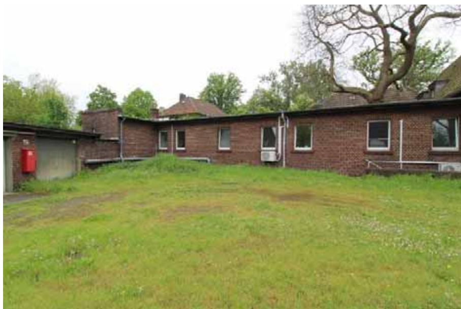
Sicht auf die Westfas- sade von Haus 11 (Shamrockring 4a) und die Garagen
