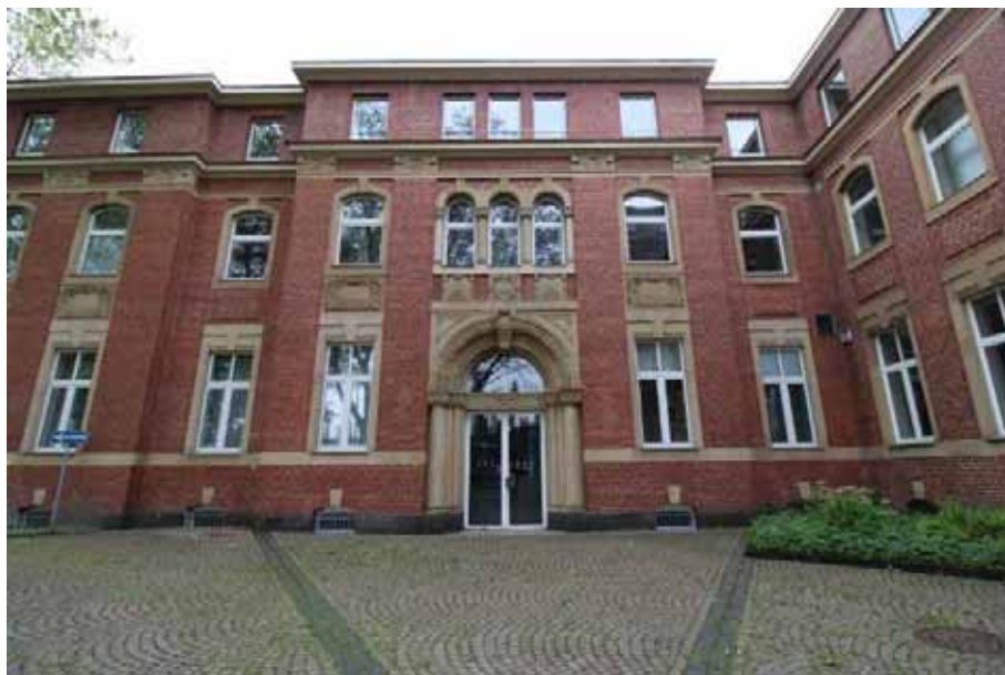
Sicht auf die Ostfas- sade von Haus 1 (Shamrockring 1)
