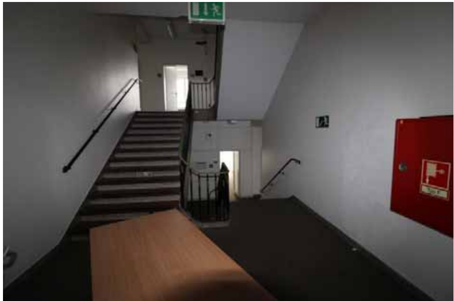
Sicht in das Haupt- treppenhaus am Turm/ 1.OG Haus 1 (Sham- rockring 1)
