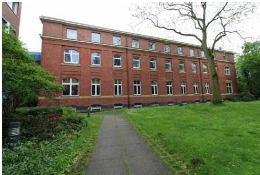
Sicht auf die Westfas- sade von Haus 1 (Shamrockring 1)
