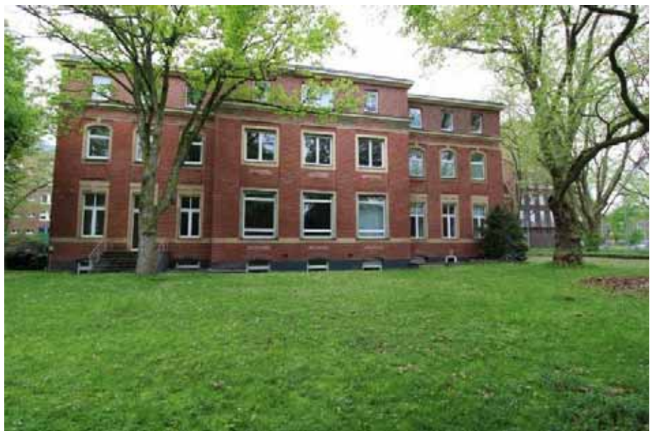
Sicht auf die Südfas- sade von Haus 1 (Shamrockring 1)
