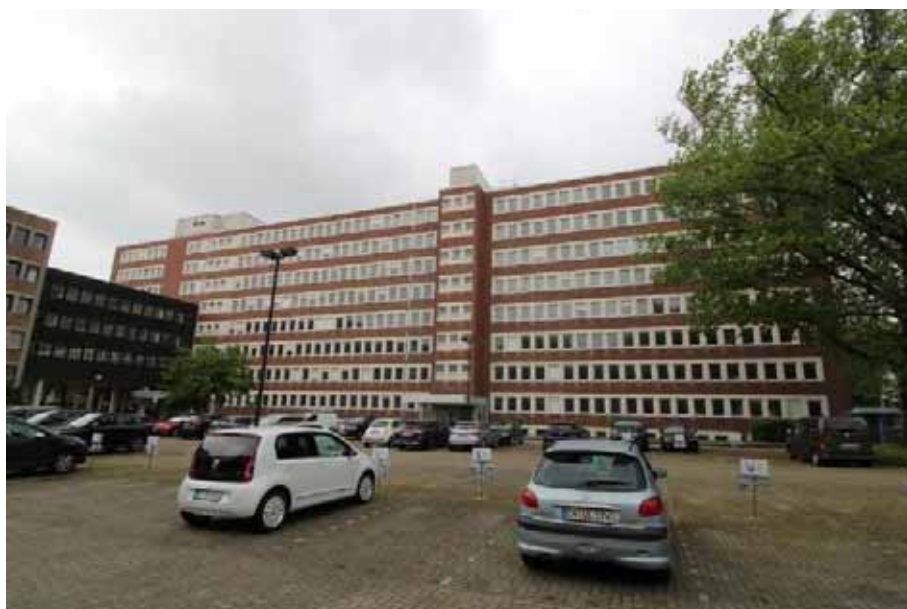
Sicht vom Parkplatz P4 aus auf die Süd- fassade von Haus 3 (Shamrockring 15)
