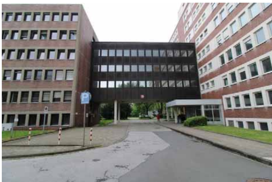
Sicht auf den Verbindungstrakt zwischen Haus 2 und Haus 3
