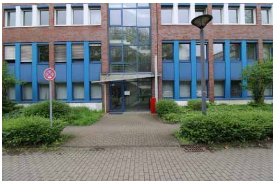
Sicht auf den Neben- eingang an der Ost- fassade von Haus 4 (Shamrockring 9)
