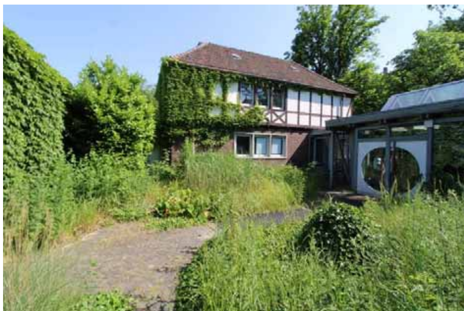
Sicht vom Innenhof aus auf die Südfassa- de von Haus 10 (Shamrockring 4)
