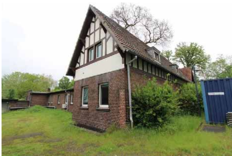
Sicht auf die Südwest- fassade von Haus 11 (Shamrockring 4a)
