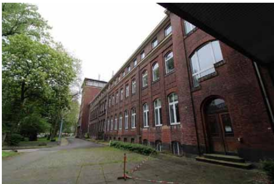
Sicht auf die Nordfas- sade von Haus 1 (Shamrockring 1)
