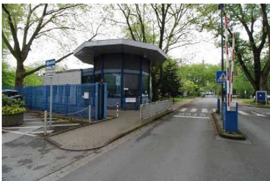
Sicht auf die Nordfas- sade von Haus 21 (Pförtner)
