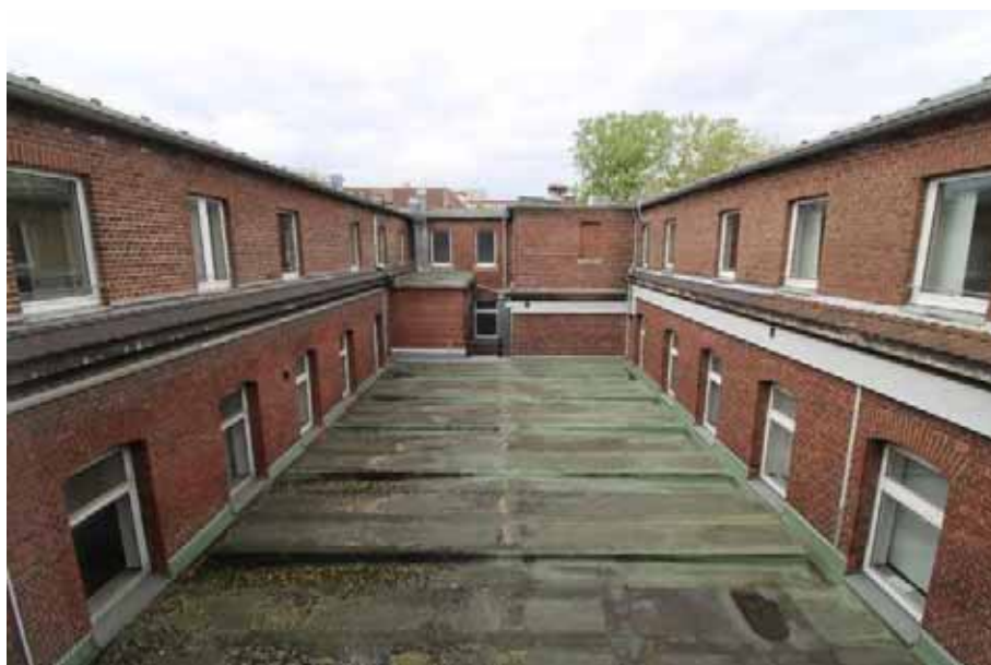
Sicht auf das Flach- dach vom Atrium/ 2.OG Haus 1 (Sham- rockring 1)
