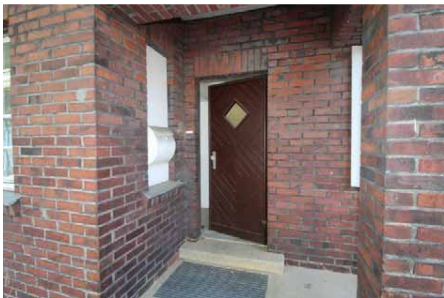
Sicht auf den Eingang an der Westfassade von Haus 13 (Grenz- weg 119)
