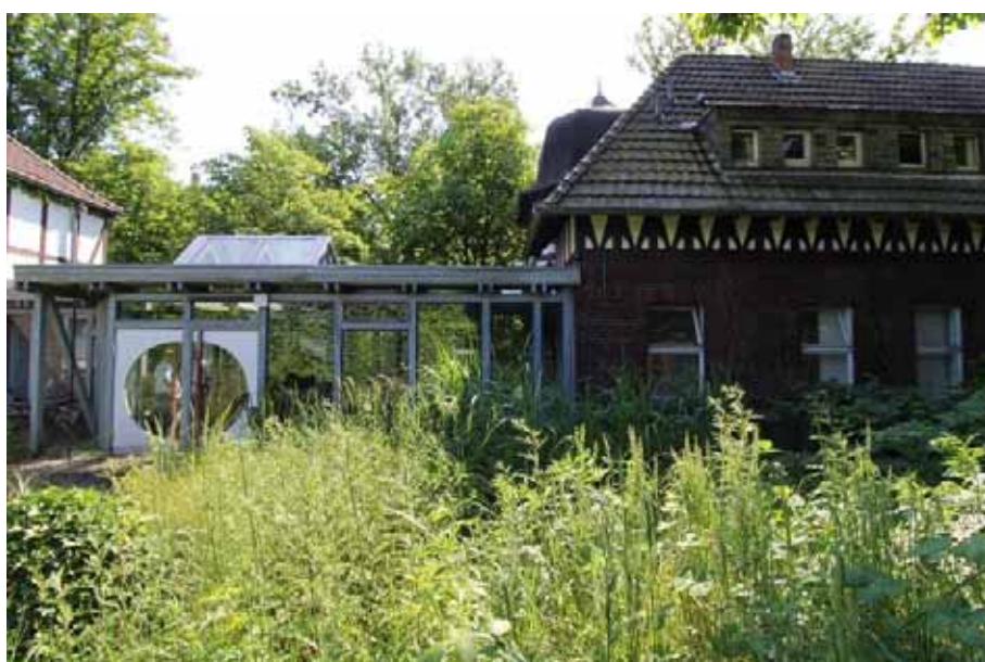
Sicht vom Innenhof aus auf den Verbind- ungsgang zwischen Haus 10 und Haus 11
