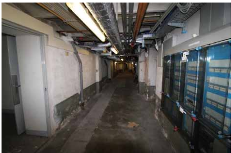
Sicht in einen Flur/ UG Haus 1 (Sham- rockring 1)
