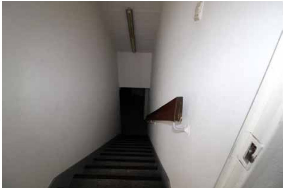
Sicht auf den Keller- abgang/UG Haus 1 (Shamrockring 1)
