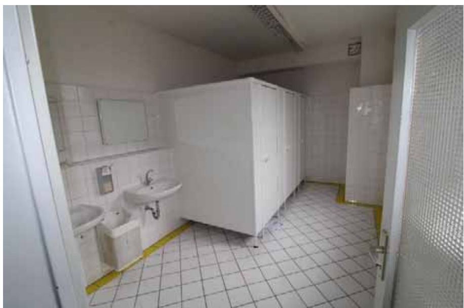
Sicht in ein WC/ 2.OG Haus 1 (Sham- rockring 1)
