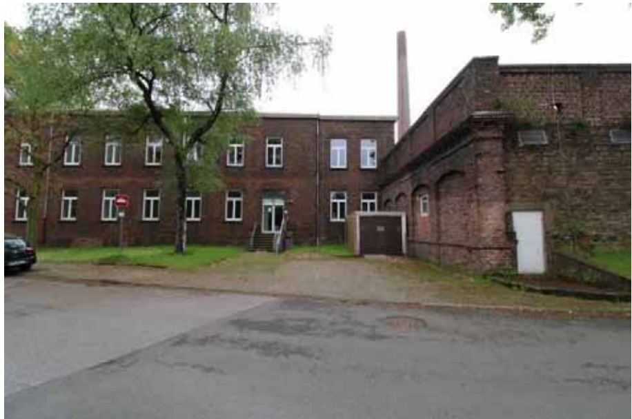
Sicht auf die Westfas- sade von Haus 6 (Shamrockring 10+11)
