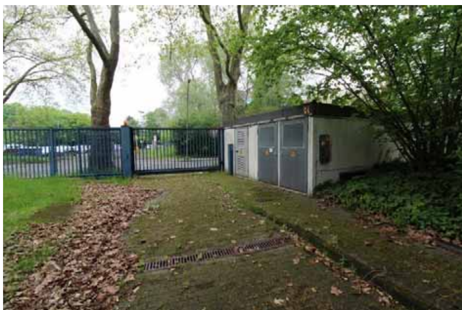
Sicht auf das Haus 28 (Transformator- häuschen) und die ehemals genutzte Tor- anlage
