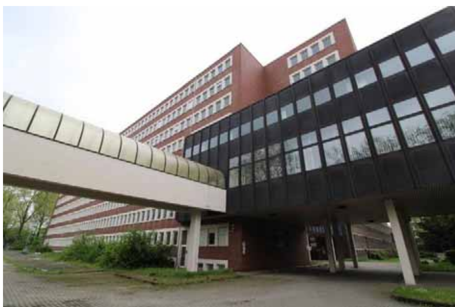
Sicht auf den rechten Bereich der Nordfas- sade von Haus 3 (Shamrockring 15)
