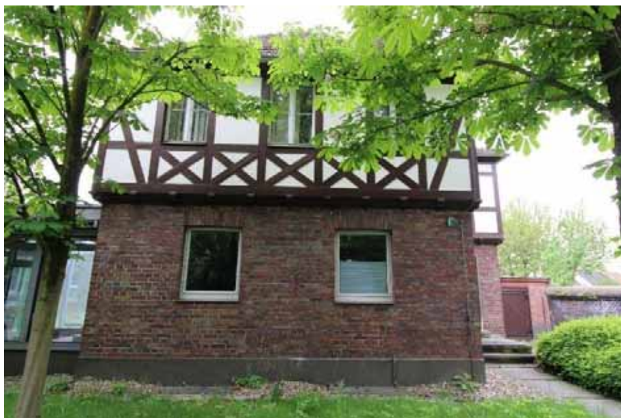
Sicht auf die Ostfas- sade von Haus 10 (Shamrockring 4)
