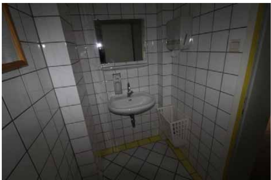
Sicht in ein WC im Turm/1.OG Haus 1 (Shamrockring 1)
