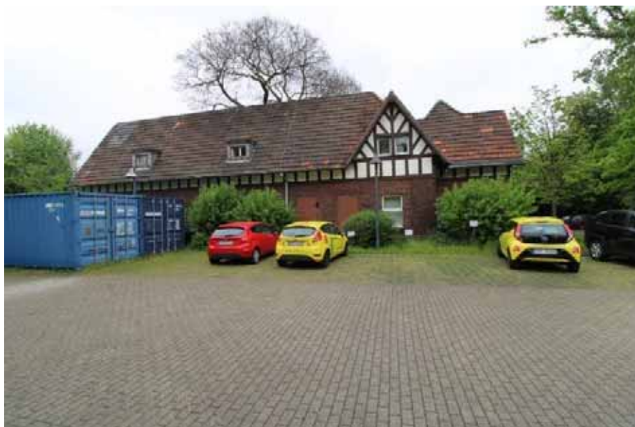
Sicht vom Parkplatz P7 aus auf die Süd- fassade von Haus 11 (Shamrockring 4a)
