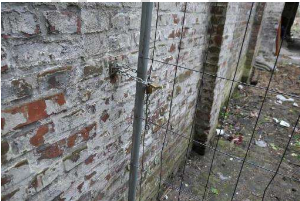
Bild 12 Bauzaun zum Hof
