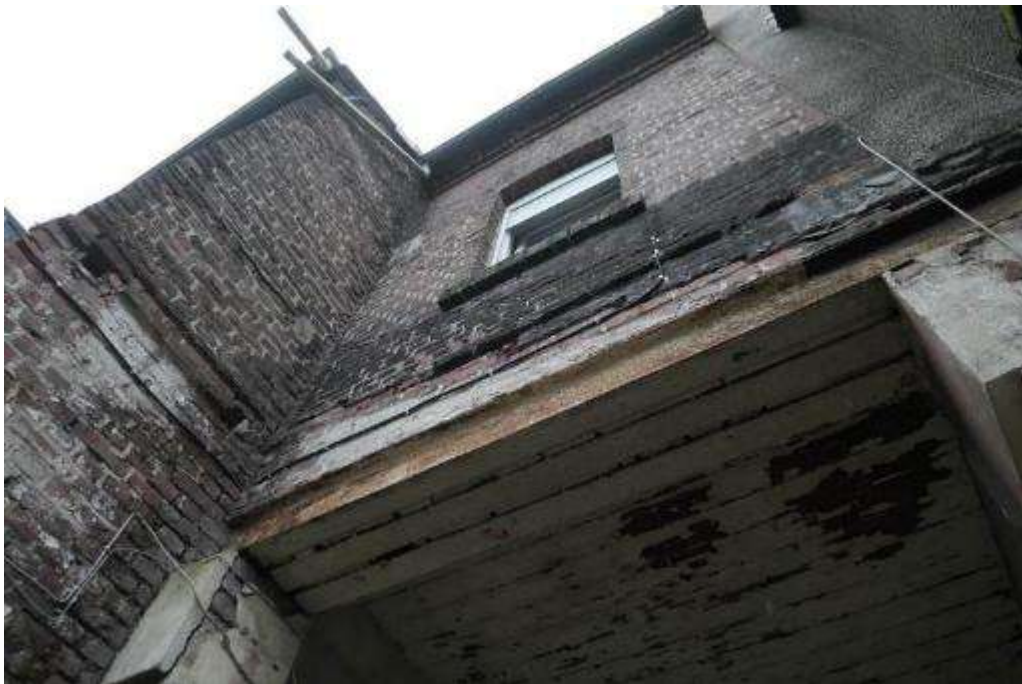
Bild 11 Blick auf die rückseitige Fassade des Vorderhauses
