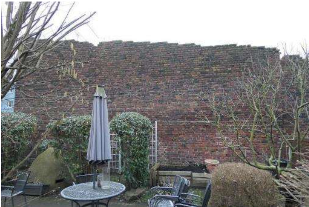
Bild 19 Blick auf die Außenmauern des Teileigentums 10 und 11 im rückwärtigen Grundstücksbereich
