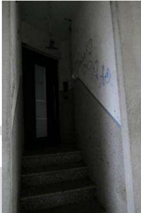
Bild 17 Treppe zum Hauseingang des Vorderhauses
