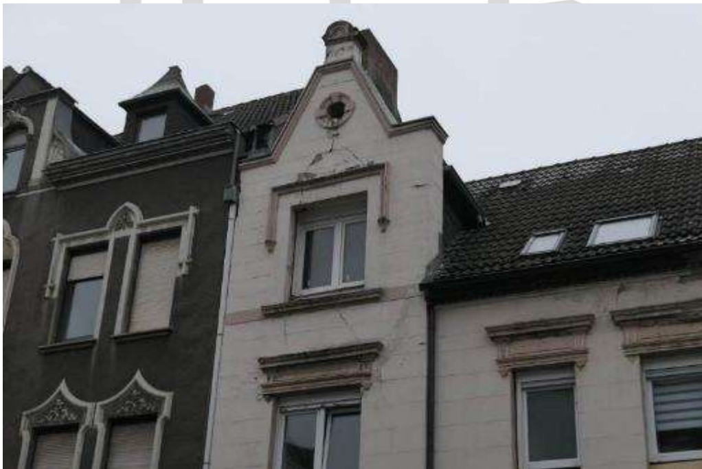
Bild 2 straßenseitige Fassade und Dach
