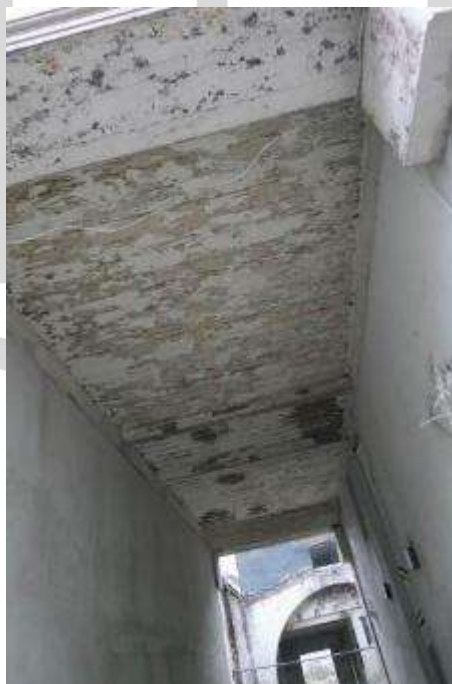
Bild 10 Zustand der Durchfahrt
