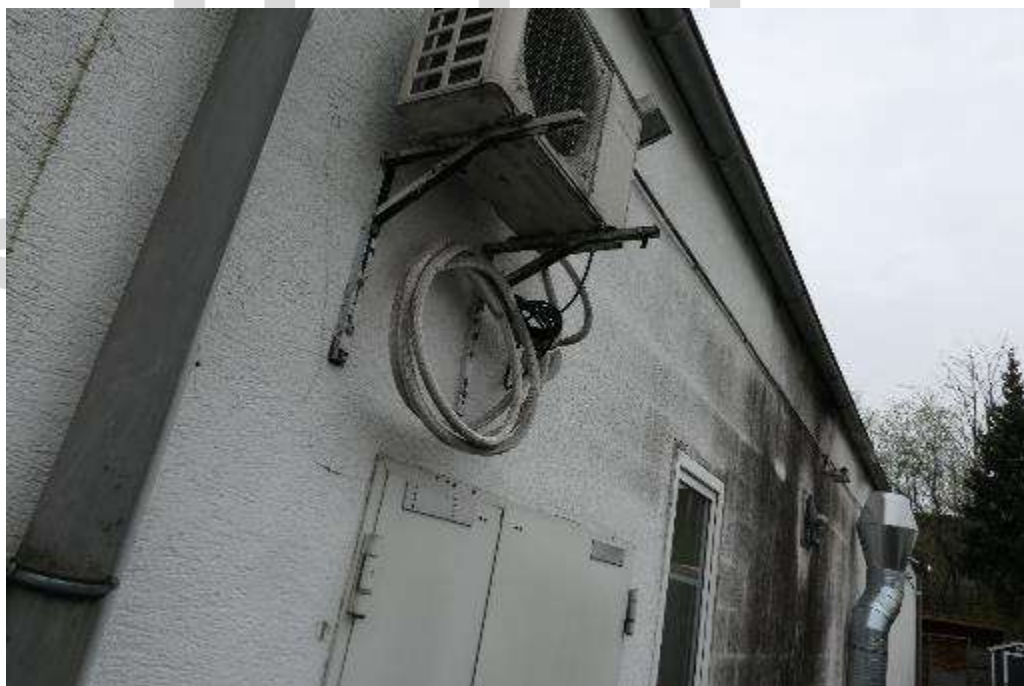
Bild 12 Fassade mit Installationen
