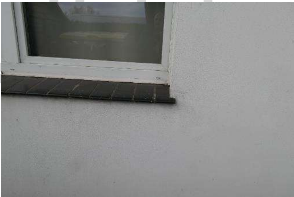
Bild 22 Kunststofffenster mit ISO Glas
