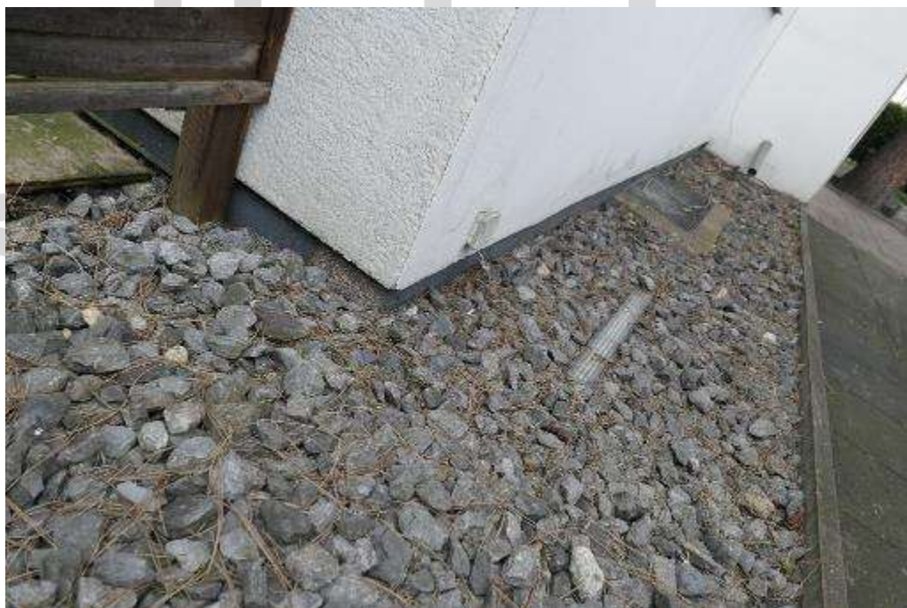
Bild 18 Fassaden mit Wärmedämmung
