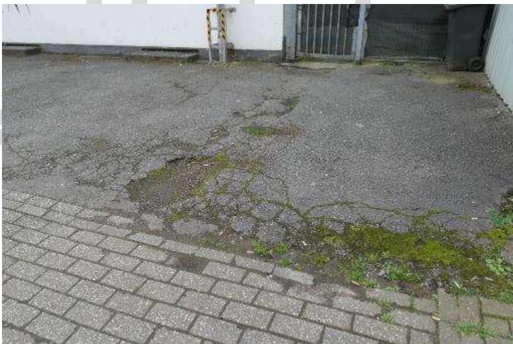
Bild 10 Stellplatzfläche vor dem Objekt
