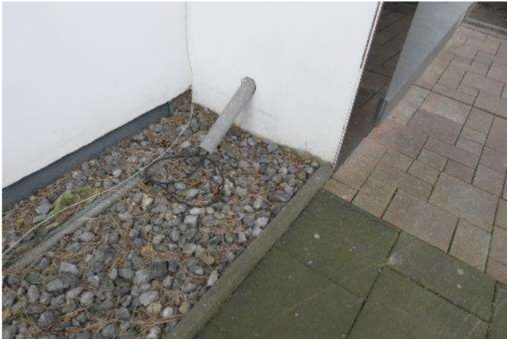
Bild 21 Kabelinstallation neben dem Haupteingang
