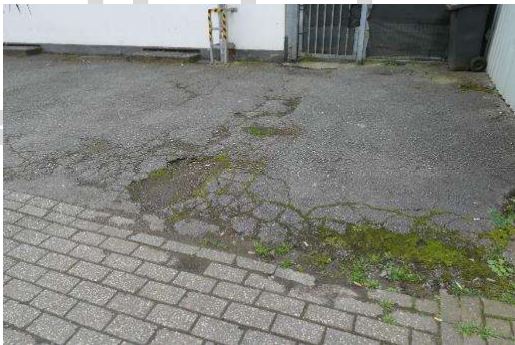
Bild 10 Stellplatzfläche vor dem Objekt
