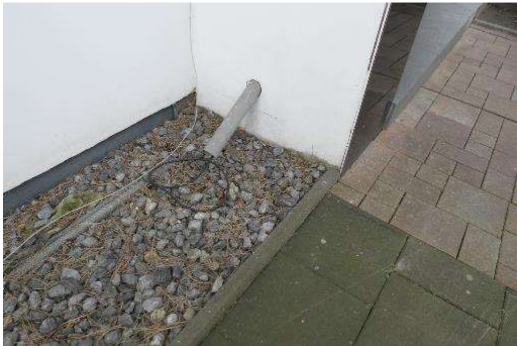
Bild 21 Kabelinstallation neben dem Haupteingang
