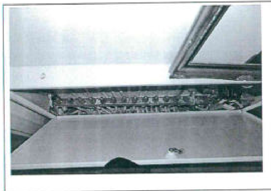
Foto 12 Anschluss Fußbodenheizung
