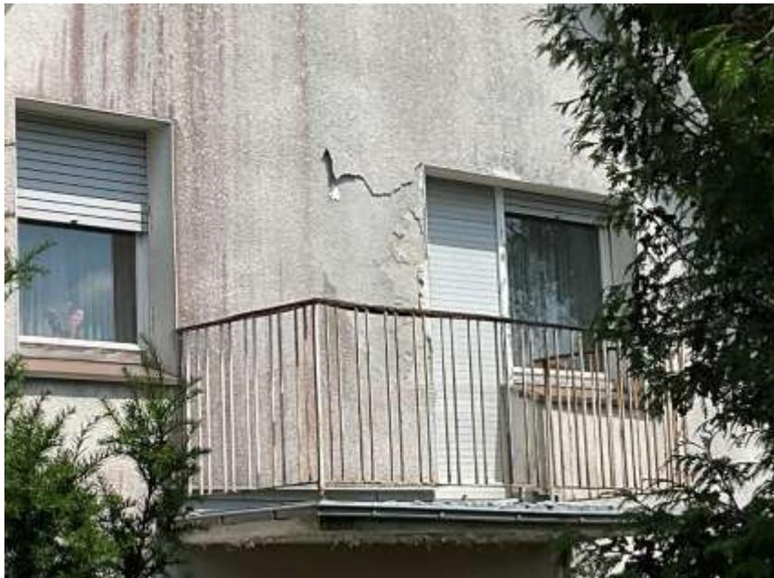
Bild 8: Beispiel für Putzschäden
