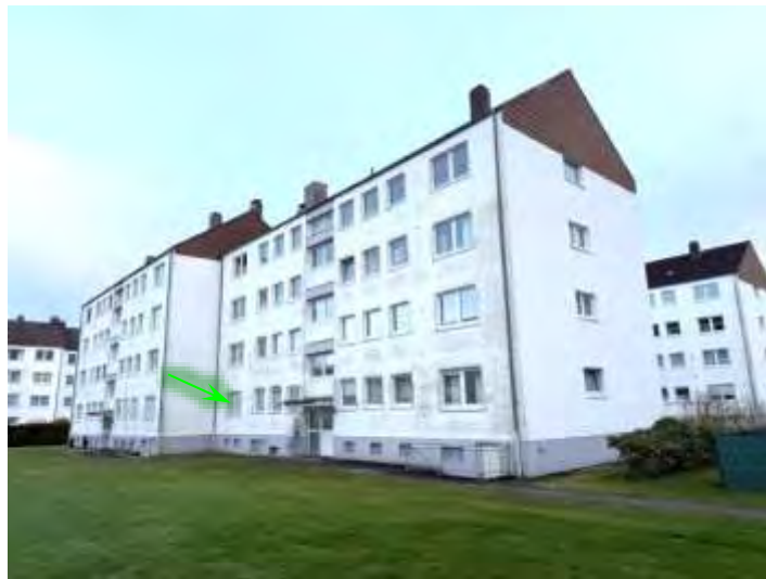
Nordwestseite – Brüsseler Straße 5
