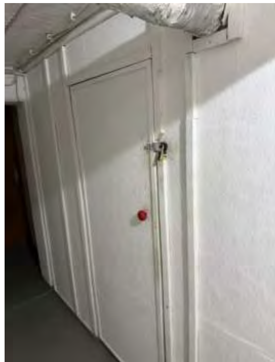
Tür zum Kellerraum Nr. 49
