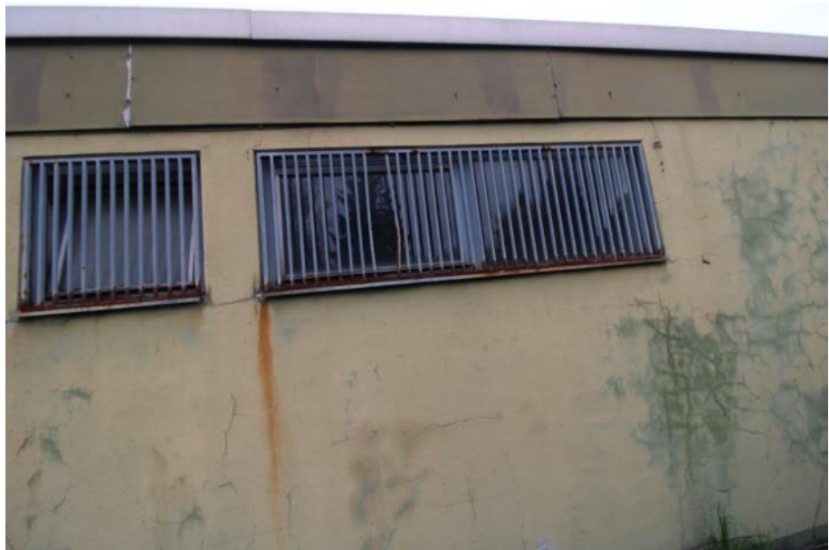
Sicht auf verbogene Fenstergitter am An- bau.
