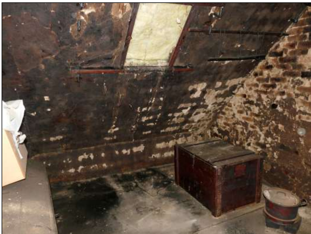
Räucherzimmer im Dachgeschoss
