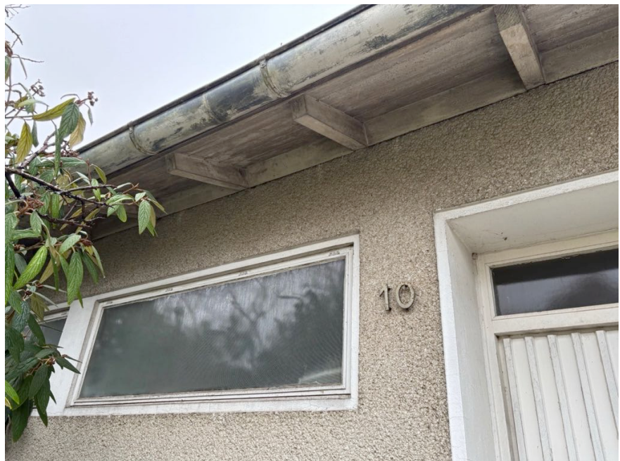
Detailansicht Fenster, Dachüberstand
