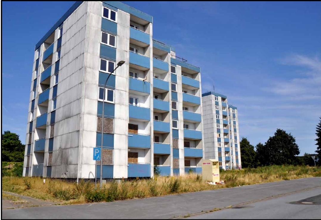
ehemalige Gebäude Sandkamp 25 und 27 (Quelle: Stadt Halle)
