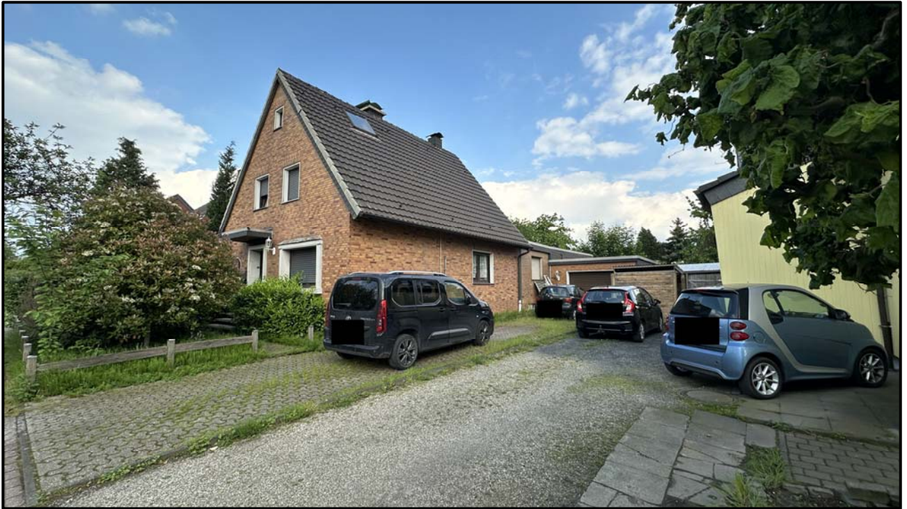
Straßenansicht Wohnhaus nebst Anbau und PKW-Garage
