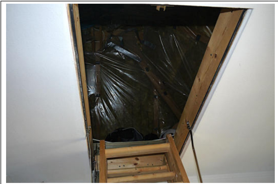
Einschubtreppe zum Spitzboden
