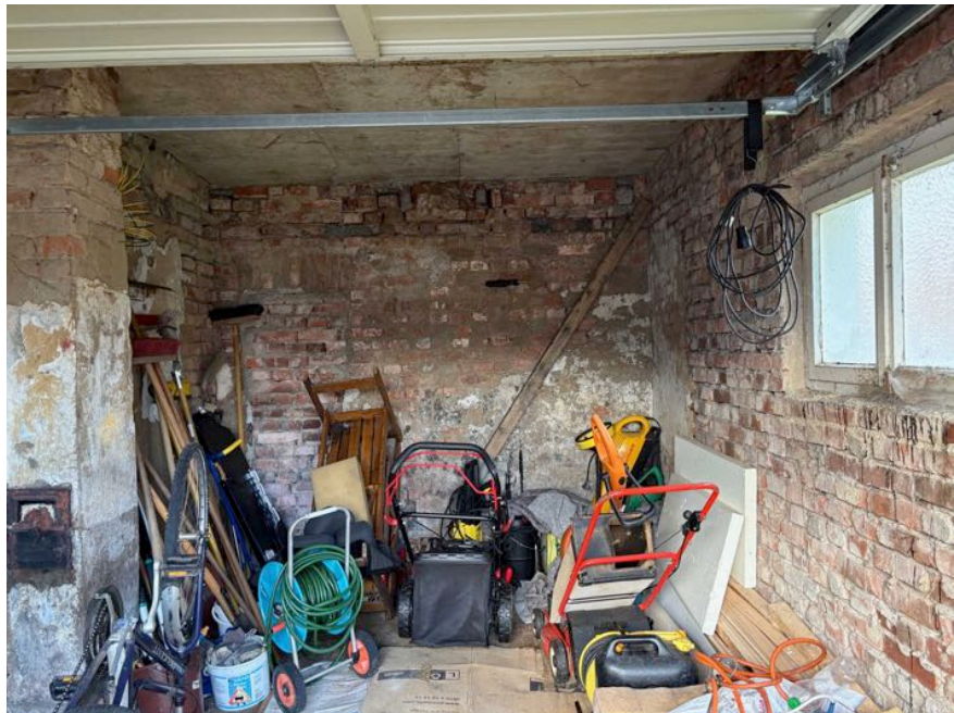
Innenansicht Garage im Anbau
