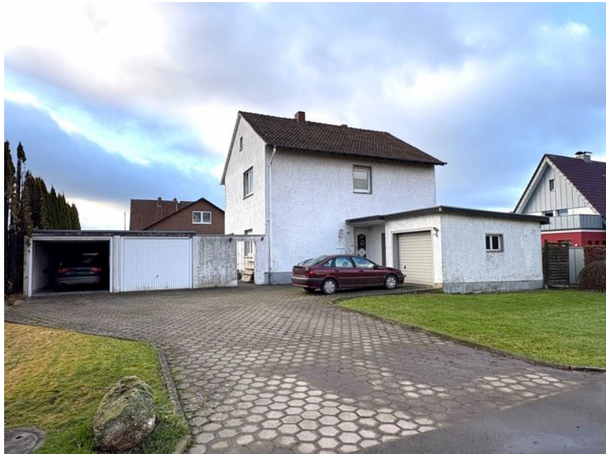
Nordansicht von der Obernackernstraße
