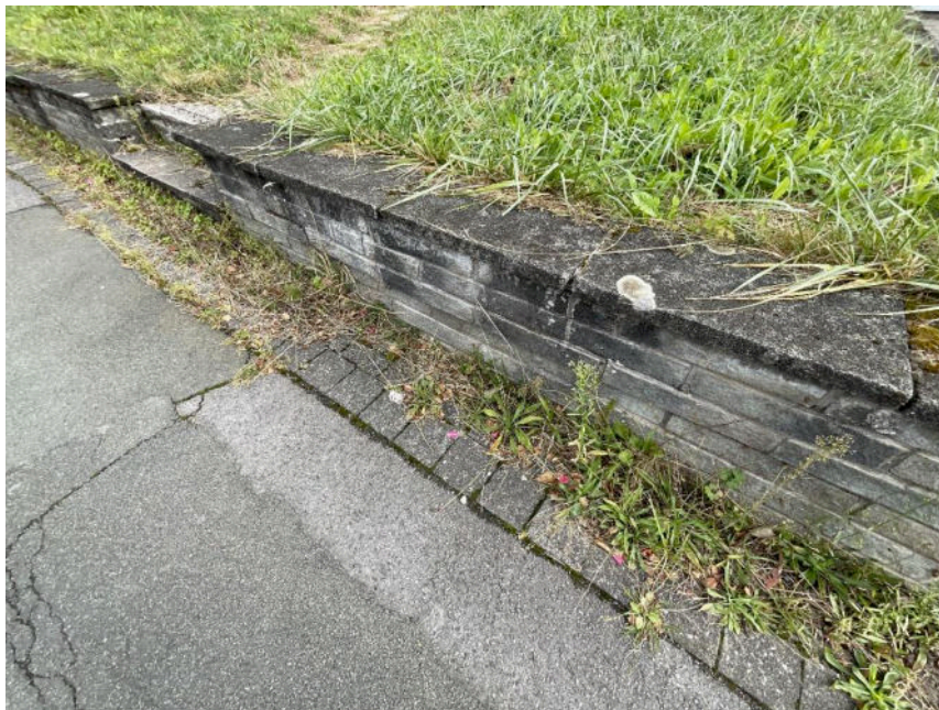
Bild 14: beschädigte Einfriedungs-Mauer Straßenseite
