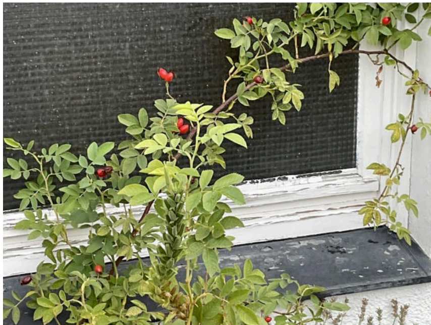
Bild 12: Abblätterung der Farbe an den Fenstern Keller/Südseite
