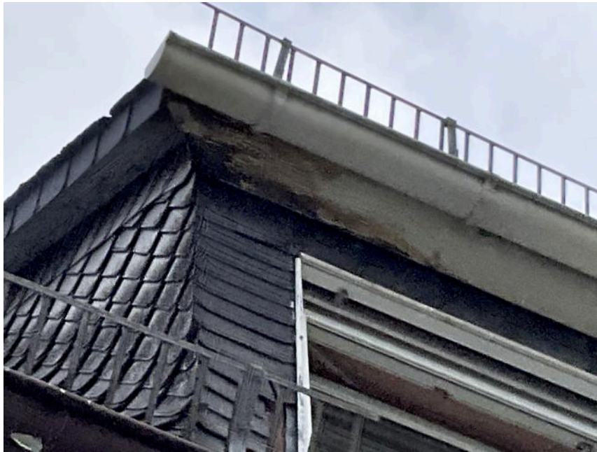
Bild 13: Holzschäden an der Gaube Südseite
