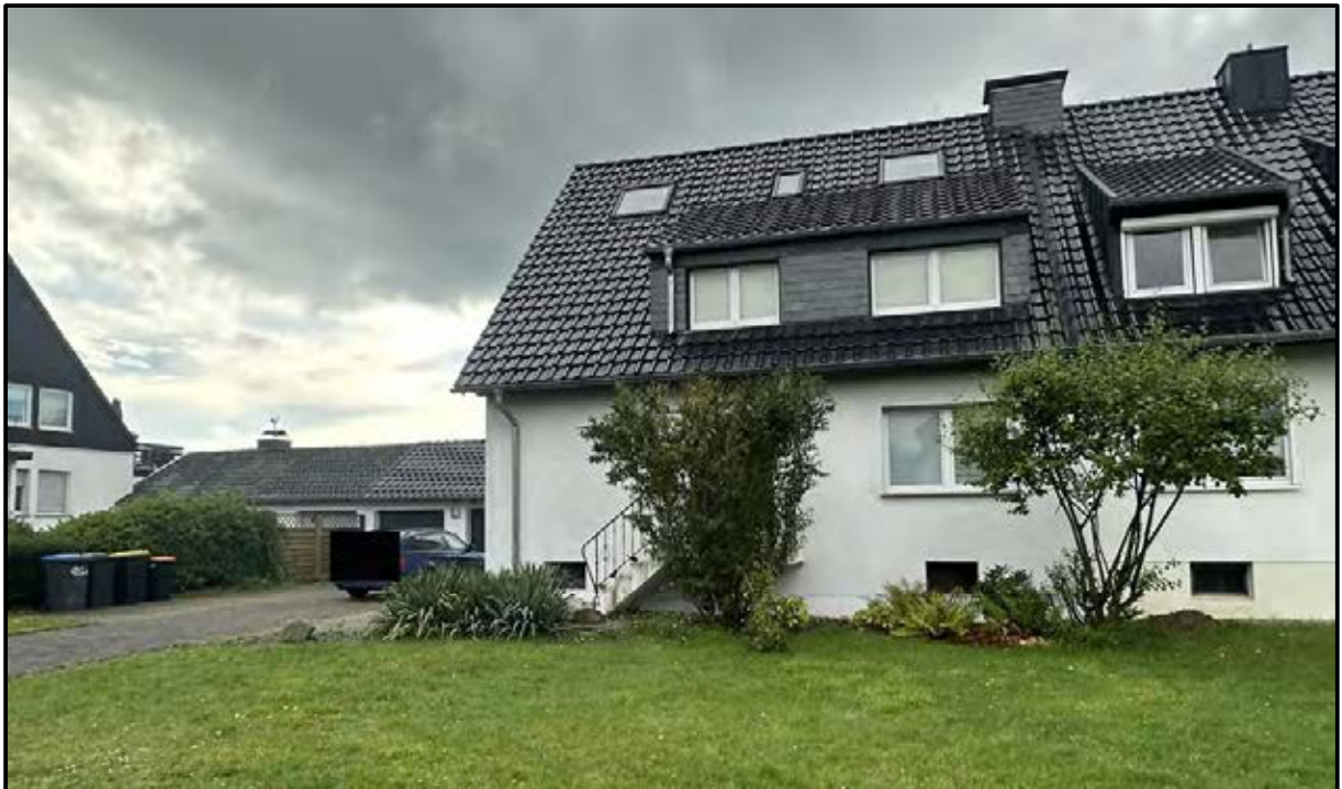
Nord-Ost-Ansicht (Wohnhaus und Nebengebäude)
