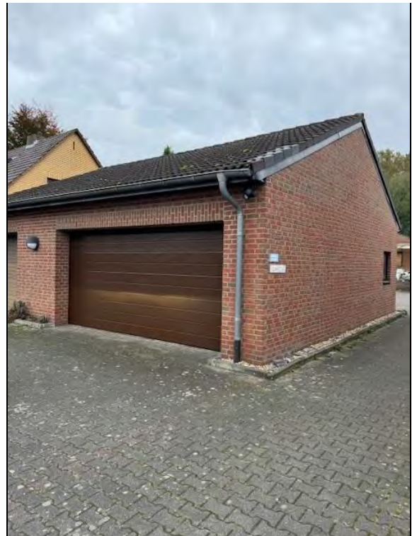
„Gebäude VII“ – Straßenansicht
