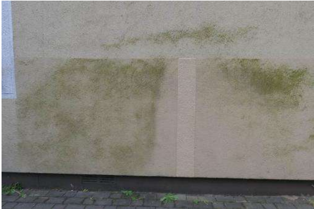
Bild 7 Fassadenverschmutzung
