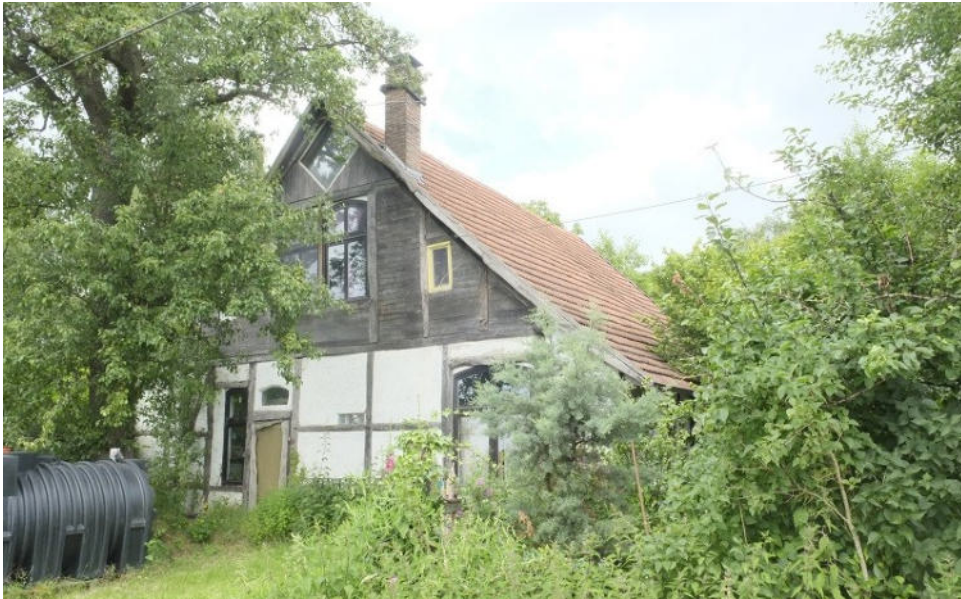
Bild 1: Ansicht von der Straßenseite
