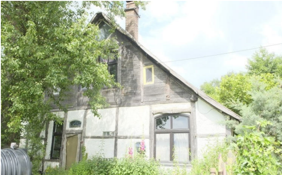
Bild 2: Blick auf die Giebelseite des Gebäudes
