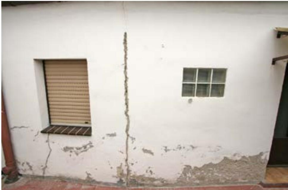
Bild 7: Risse in und Abplatzungen an dem vorderen Teil der Fassade des Anbaus
