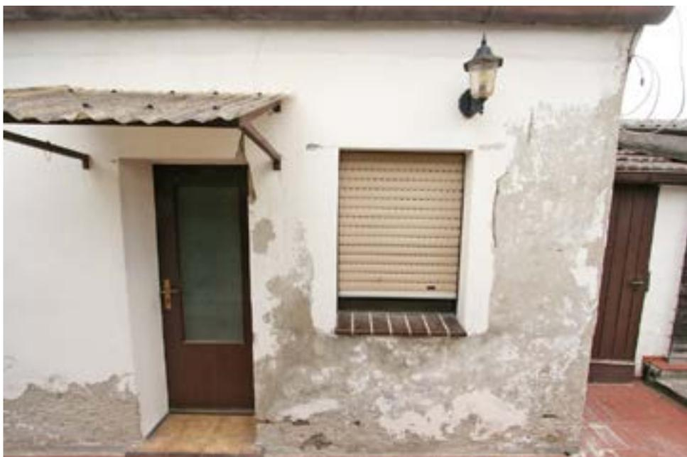
Bild 8: Risse in und Abplatzungen an dem hinteren Teil der Fassade des Anbaus
