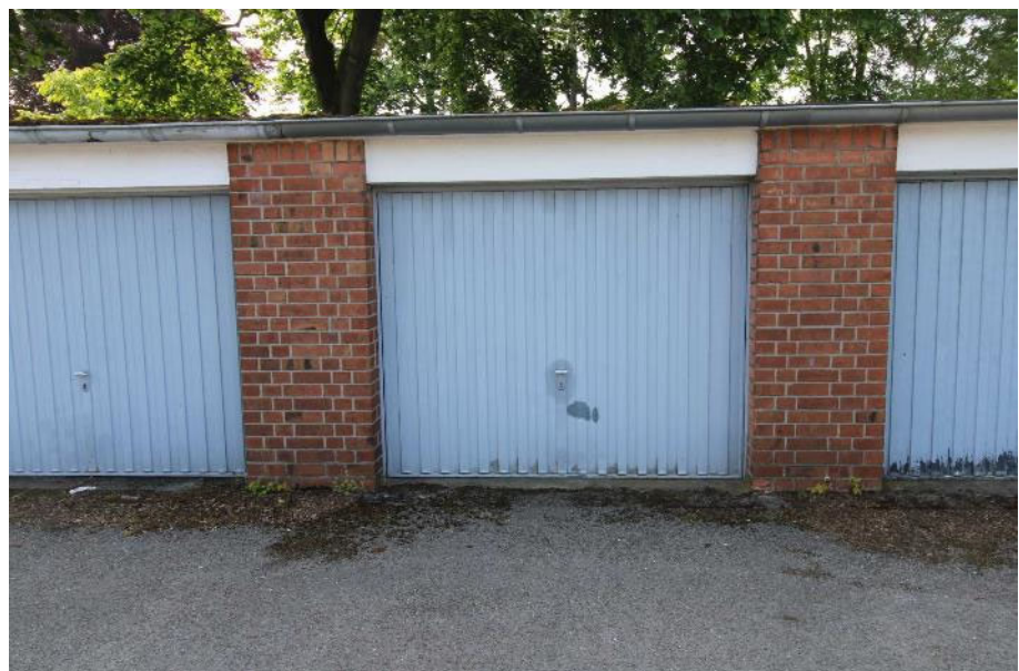
Sicht vom Garagenhof Flurstück 426 auf die Pkw-Garage Flurstück 422 des zu bewerten- den Objekts
