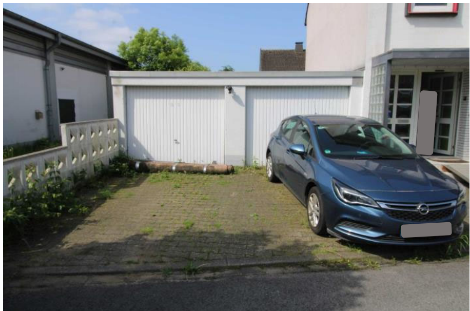
Sicht von der Katharinastraße aus auf die Pkw-Garagen an der linken Giebelseite des zu bewertenden Objekts
