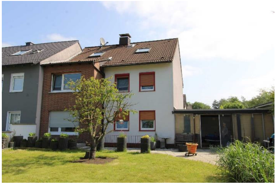
Sicht vom Garten aus auf die Rückansicht des zu bewertenden Objekts
