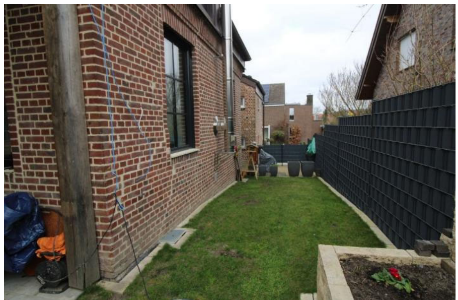
Blick auf die Nordostseite des Grundstücks
