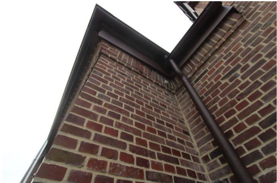
Nördliche Gebäude- ecke Schmiede Zu- stand
