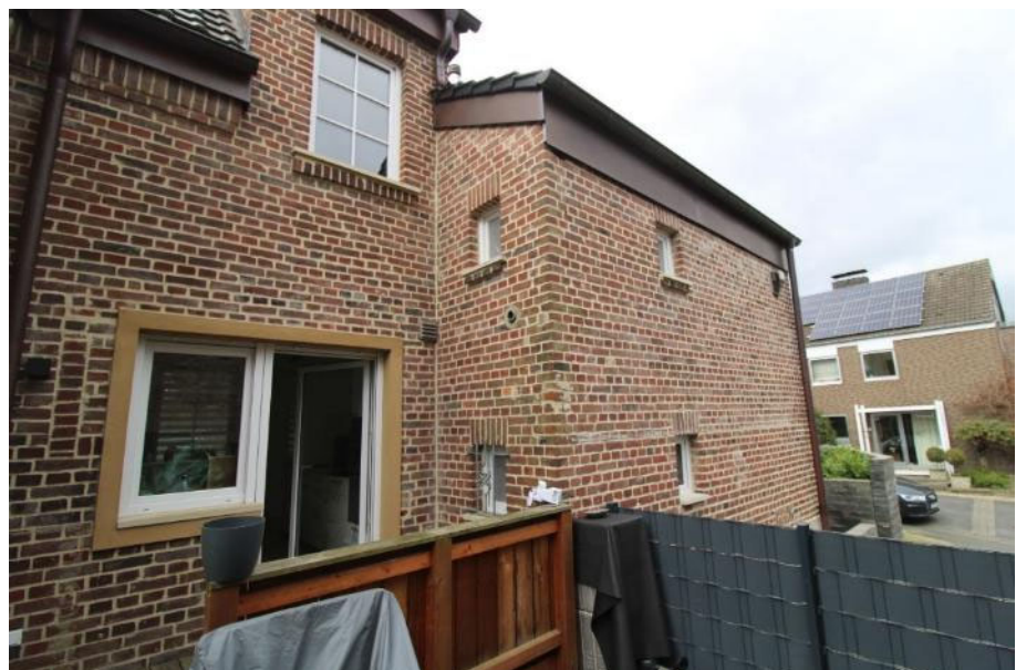
Blick auf die nordöstli- che Gebäudeseite des Wohnhauses
