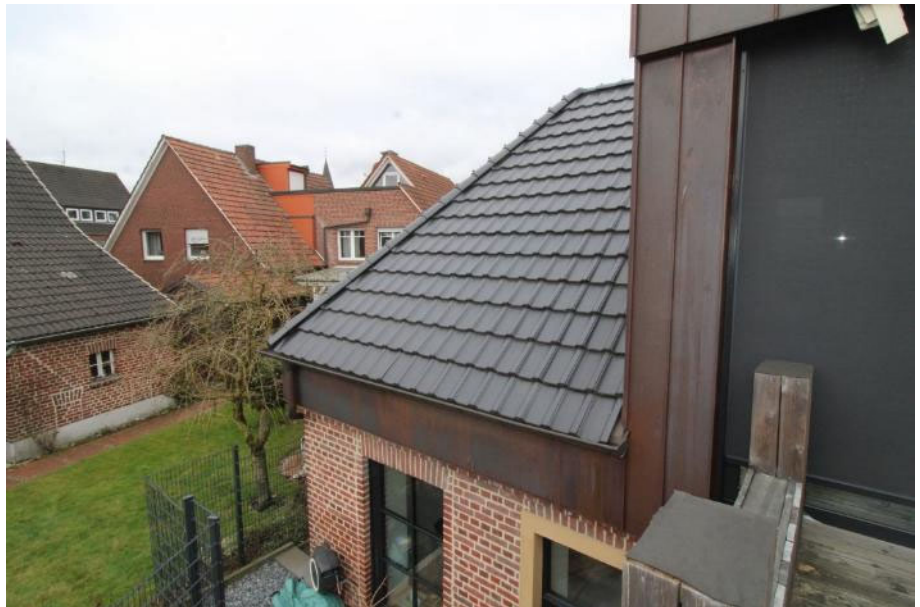
Anschluss Terrassenüberdachung/Gaube/Dach Zustand
