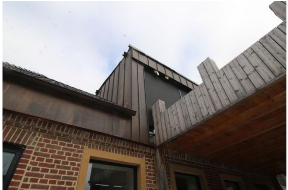
Anschluss Terrassen- überdachung/Gaube Zustand (Südwet)
