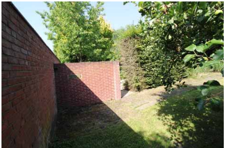
Mauer zum Nachbarn und zum nordöstlichen Gartenbereich
