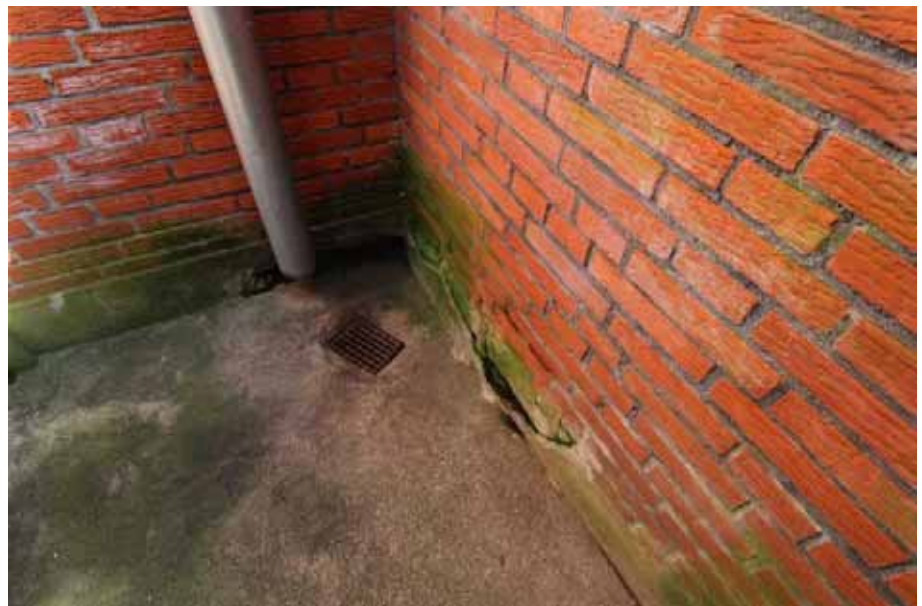
Kelleraußentreppe Bodenplatte und Mau- erwand
