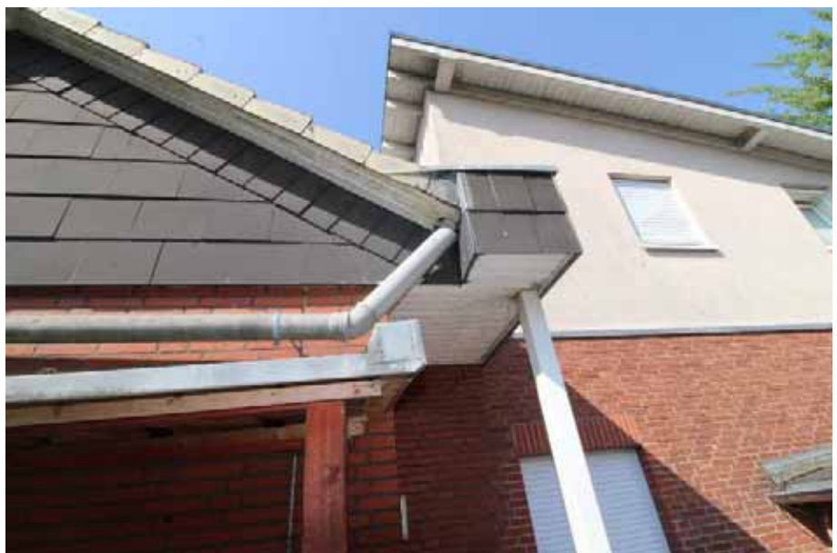
Nordöstliche Gebäudeseite/Anschluss Anbau
