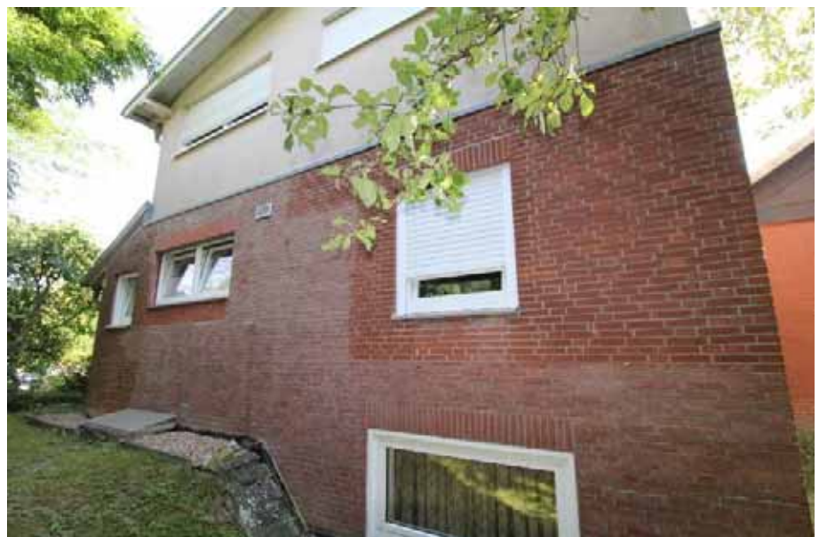
Südwestseite des Gebäudes
