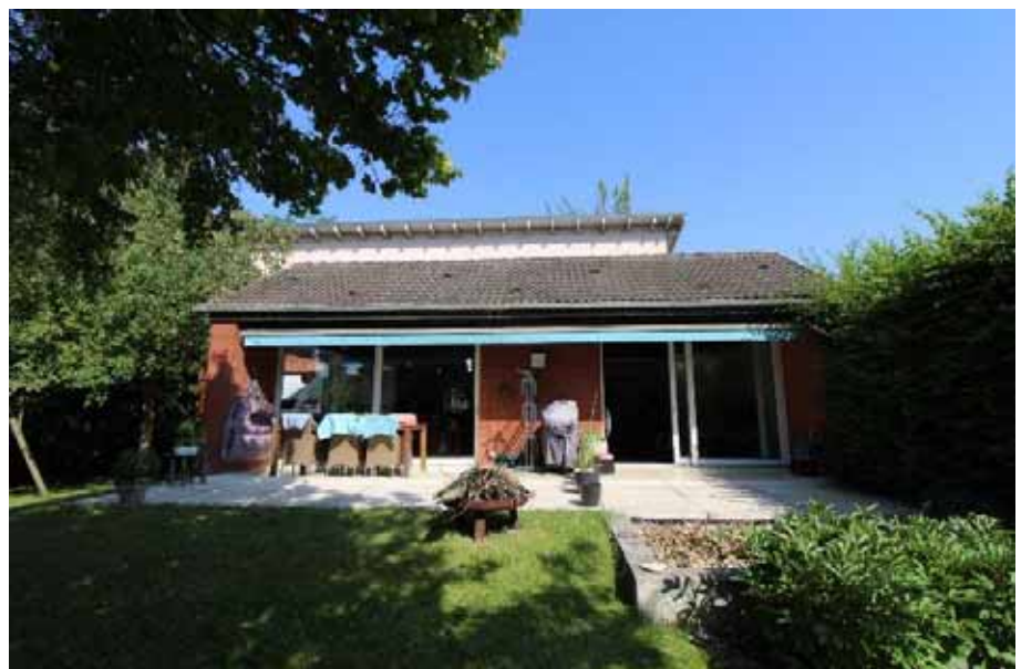
Terrasse/Ansicht von Südosten
