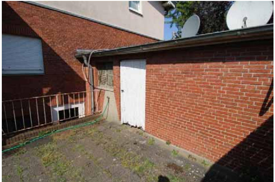
Bereich hinter der Garage mit Kelleraußentreppe
