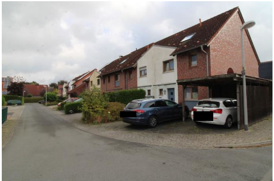
Blick von der Straße.
