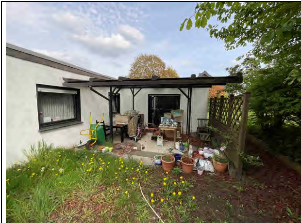
Foto 7: Blick aus westlicher Richtung auf das Bewertungsobjekt
