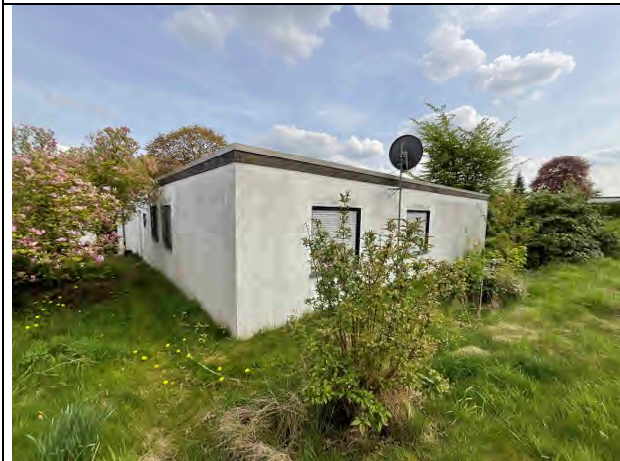
Foto 9: Blick aus nordwestlicher Richtung auf das Bewertungsobjekt
