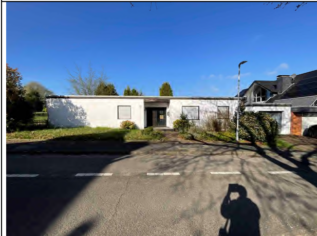
Foto 3: Blick aus östlicher Richtung auf das Bewertungsobjekt
