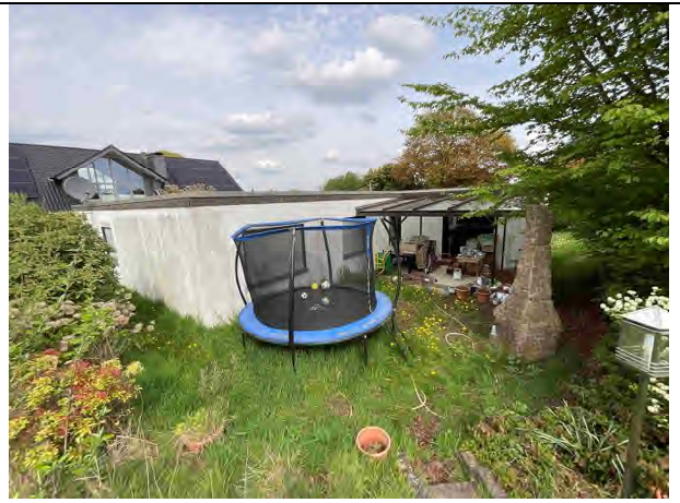
Foto 8: Blick aus südwestlicher Richtung auf das Bewertungsobjekt
