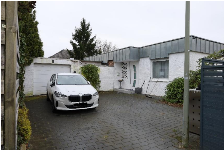
Ansicht in die Einfahrt
