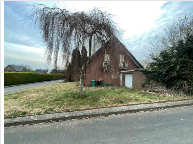
Foto 7: Blick aus westlicher Richtung auf das Bewertungsobjekt
