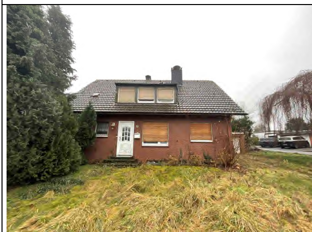
Foto 5: Blick aus nördlicher Richtung auf das Bewertungsobjekt
