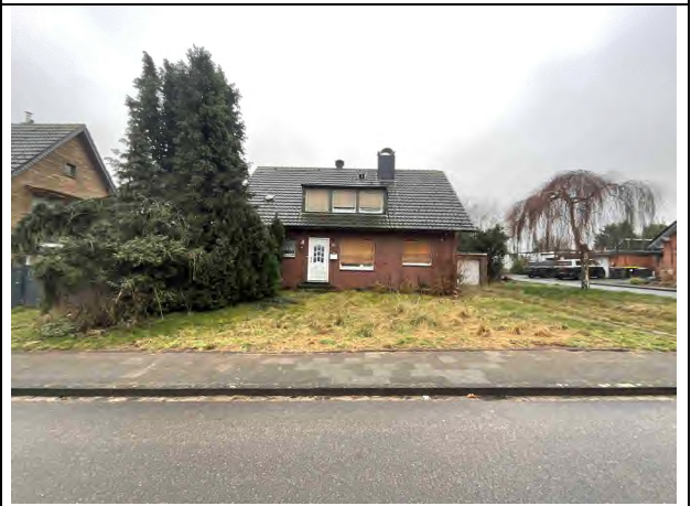
Foto 4: Blick aus nördlicher Richtung auf das Bewertungsobjekt
