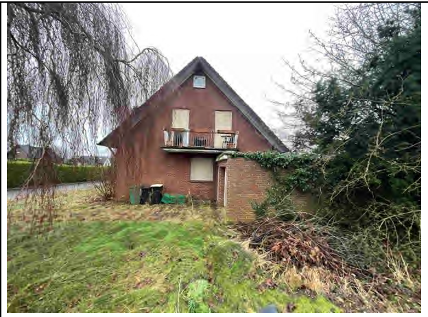
Foto 8: Blick aus westlicher Richtung auf das Bewertungsobjekt
