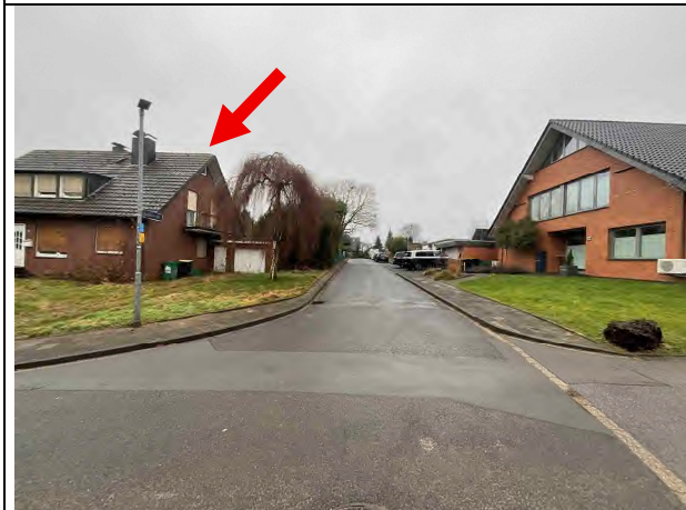
Foto 3: Blick aus nördlicher Richtung in die Lindenstraße
