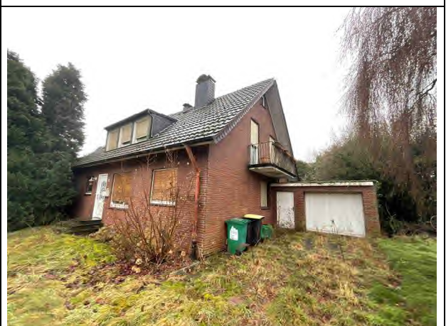
Foto 6: Blick aus nordwestlicher Richtung auf das Bewertungsobjekt
