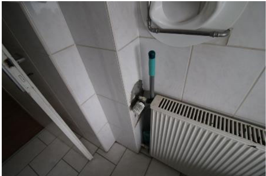
Zustand Heizkörperan- schluss Badezimmer Dachgeschoss
