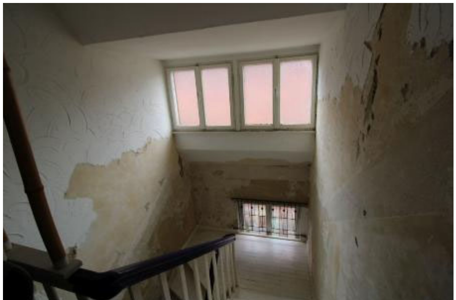
Treppenhaus Dachge- schoss
