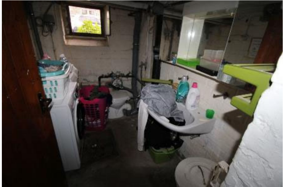
Waschkeller mit Toilette und Waschbecken
