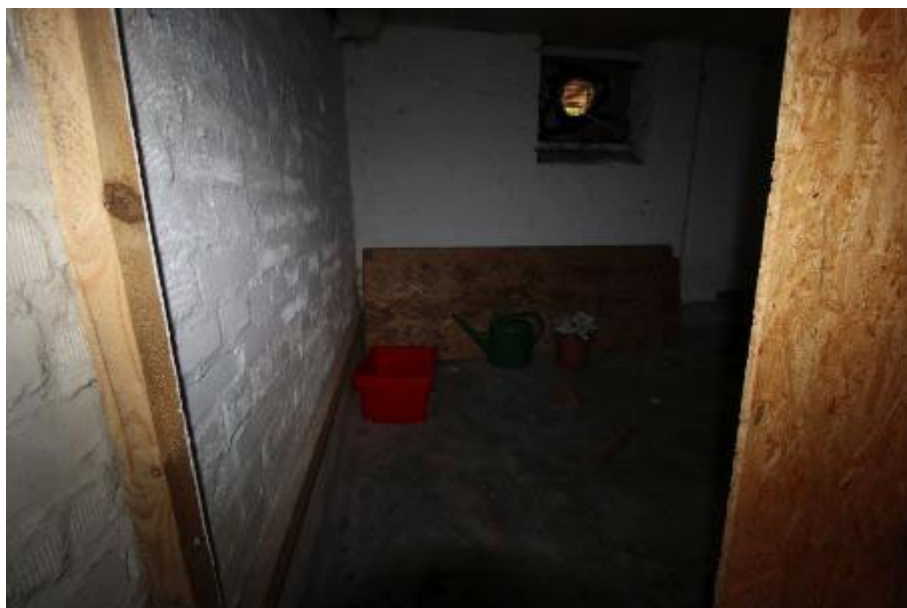
Noch ein weiterer Kellerraum
