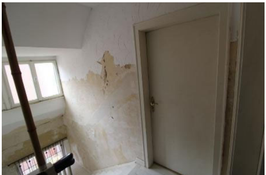
Treppenhaus Dachge- schoss/ Eingang Mansarde
