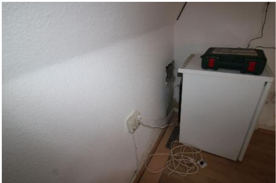
Mansarde Zustand Au- ßenwand und Wand zur Dachgeschoss- wohnung
