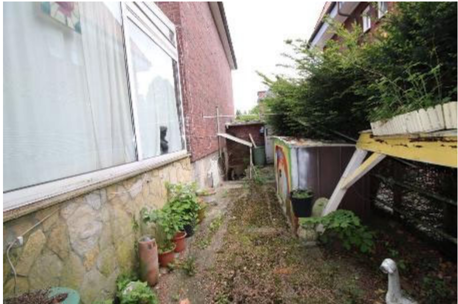
Bereich im Garten hinter der Garage/ östliche Grundstücksseite
