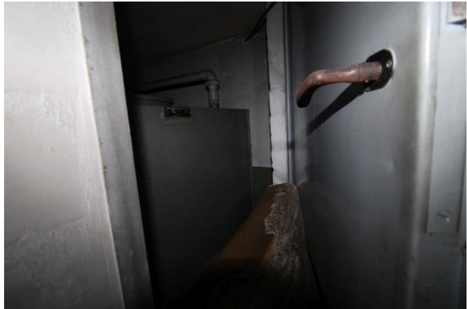
Sicht in den Tankraum / EG
