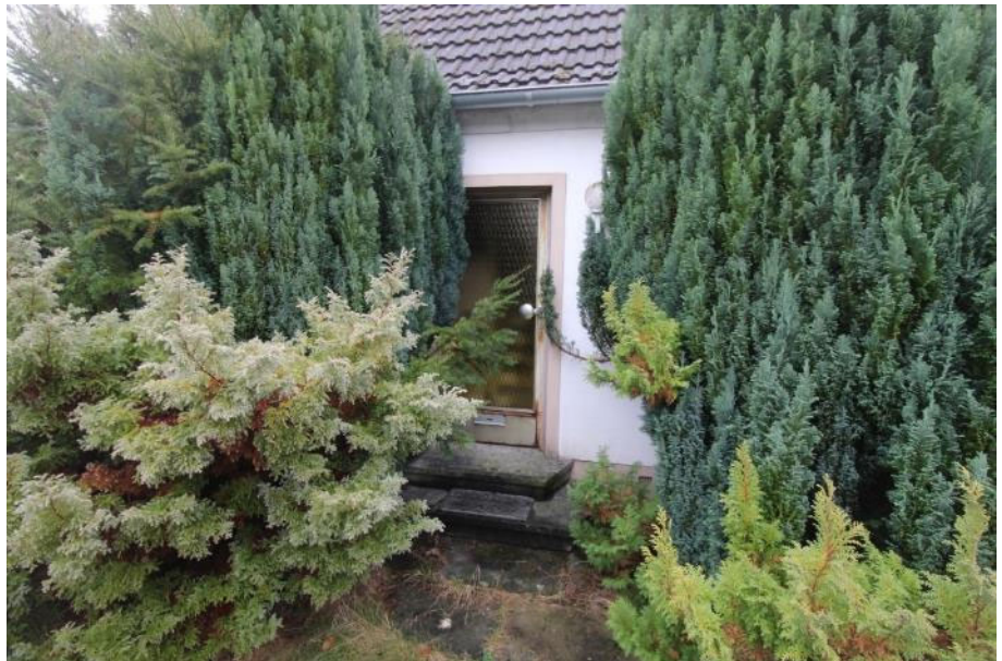
Sicht auf den Haus- eingang an der West- fassade des zu be- wertenden Objekts
