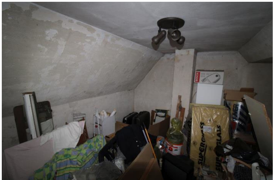
Sicht in das Zimmer 3 / DG
