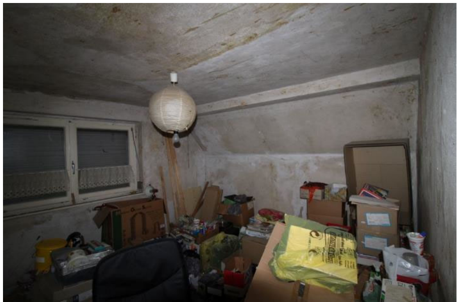
Sicht in das Zimmer 2 / DG
