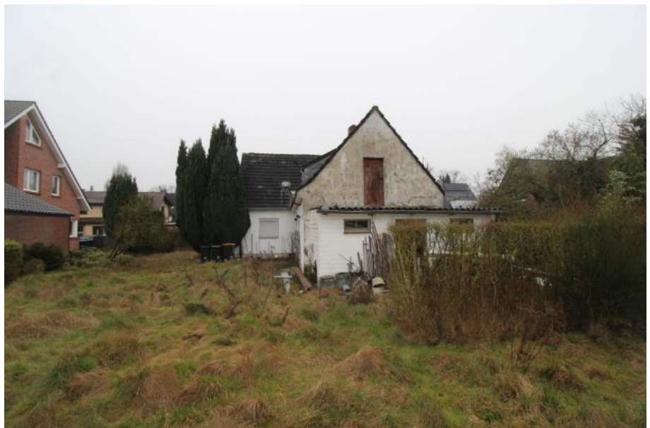
Sicht vom Garten aus auf die Ostfassade des zu bewertenden Objekts
