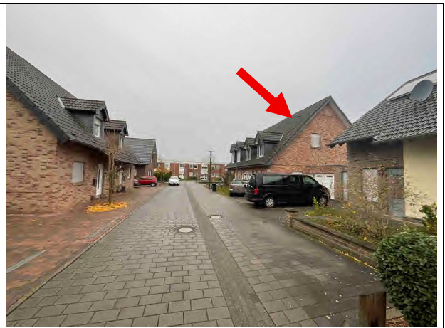
Foto 2: Blick aus östlicher Richtung in die Ilmenauer Straße
