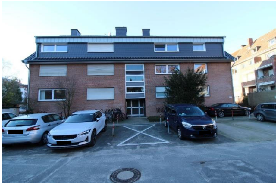
Sicht von der Straße aus auf die Vorderfas- sade des Wohnhau- ses
