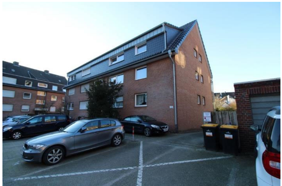
Sicht von der Straße aus auf die Vorder- und Giebelfassade rechts des Wohnhauses
