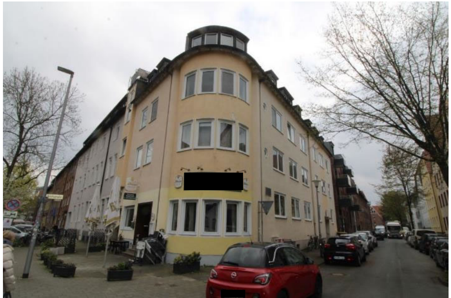
Sicht von der Straße aus auf das zu bewertende Objekt
