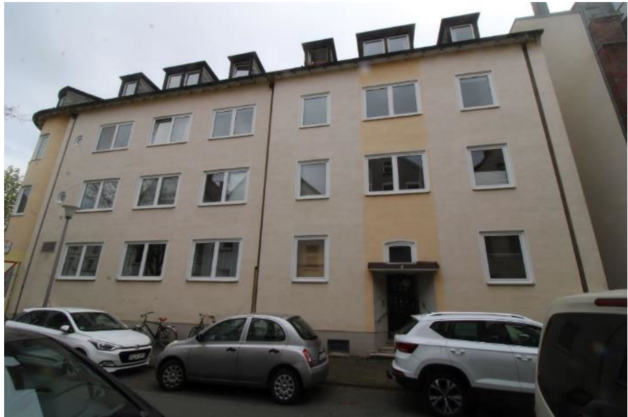
Sicht von der Teich- straße aus auf das zu bewertende Objekt
