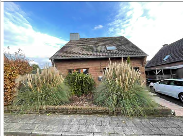
Foto 3: Blick aus nordwestlicher Richtung auf das Bewertungsobjekt
