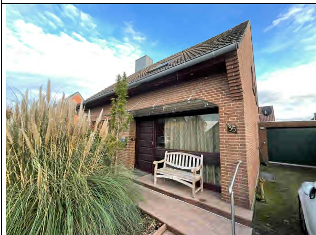
Foto 5: Blick aus westlicher Richtung auf das Bewertungsobjekt
