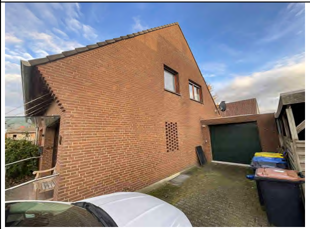
Foto 4: Blick aus westlicher Richtung auf das Bewertungsobjekt
