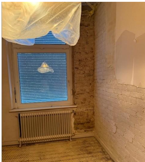
Bild 15: Rohbau Raum EG
