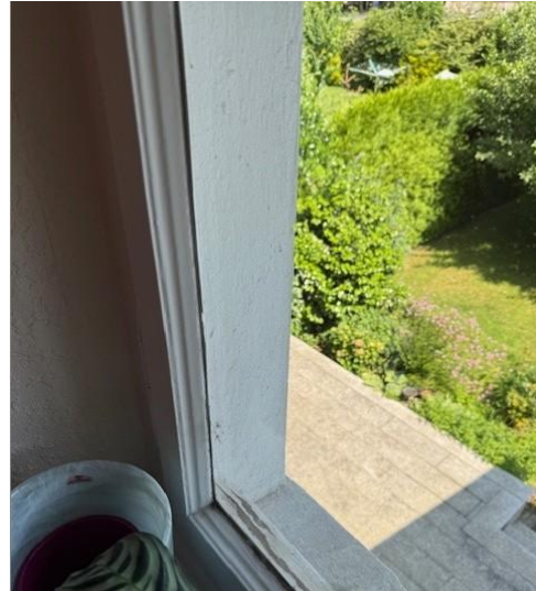
Bild 10: Holzfenster Einfachverglasung
