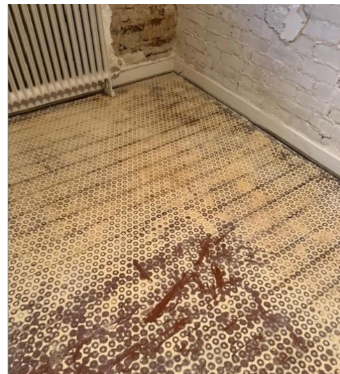
Bild 16: Rohbau Raum EG
